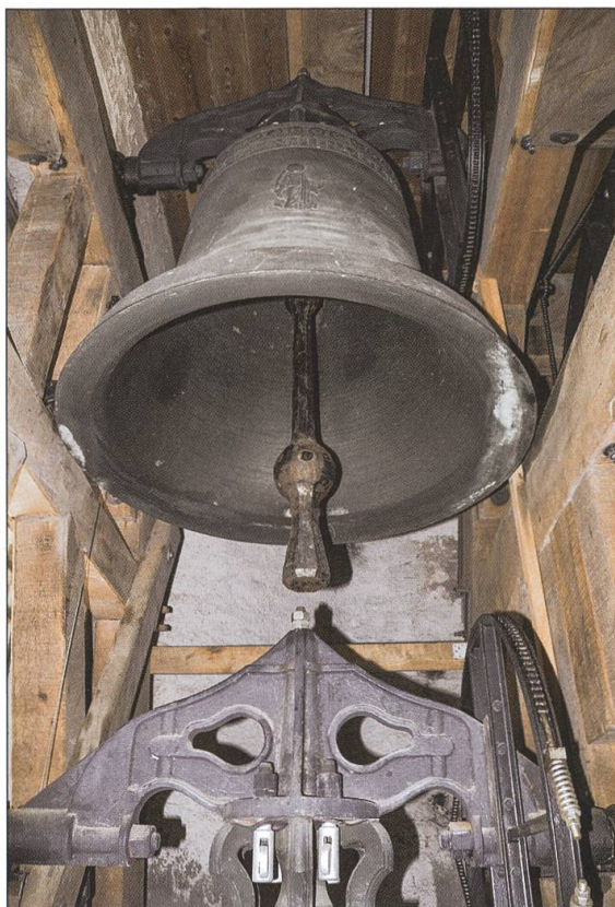
Im südlichen Turm hängen vier Glocken, links zwei kleine, in der Mitte des Glockenstuhls die grösste Glocke (rechts). Die Glocken dieses Turmes werden auch für die Viertelstunden- und Stundeschläge genutzt.
