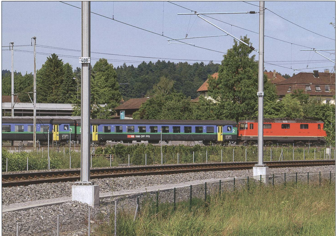
Die «Kriegsschleife» (im Vordergrund) führt mitten durch die Baumschule Haller. Im Hintergrund befährt im Juni 2005 ein Schnellzug die Stammstrecke Olten–Luzern.
