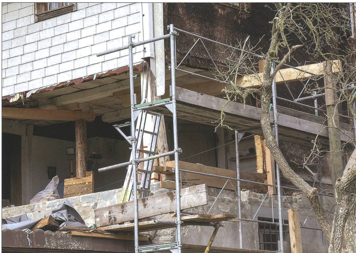
Grosse Restaurationsarbeiten im Frühling 2005. Kellermauern, Kellerdecke, Küchenwände und Küchenboden mussten dauerhaft statisch gesichert und mit viel Titan und Stahl, Beton und Mörtel, Holz und Steinen saniert werden.
