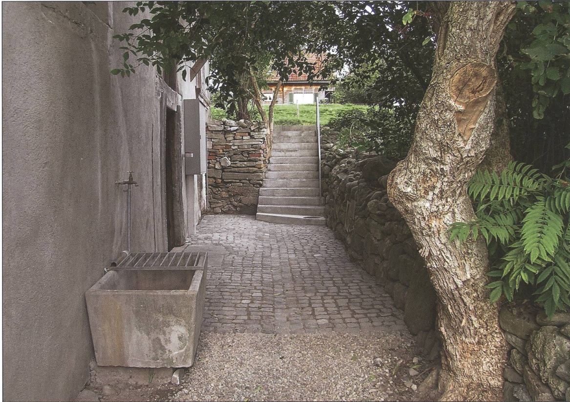
Abgeschlossene Sanierung im September 2009 des Kellerzugangs und der Abwasser- und Wasserleitungen. Als eine wunderbare Bsetzi dienen in Zweitverwendung 200-jährige Steine der alten Strasse am Schwanderholzstutz ob Wolhusen.
