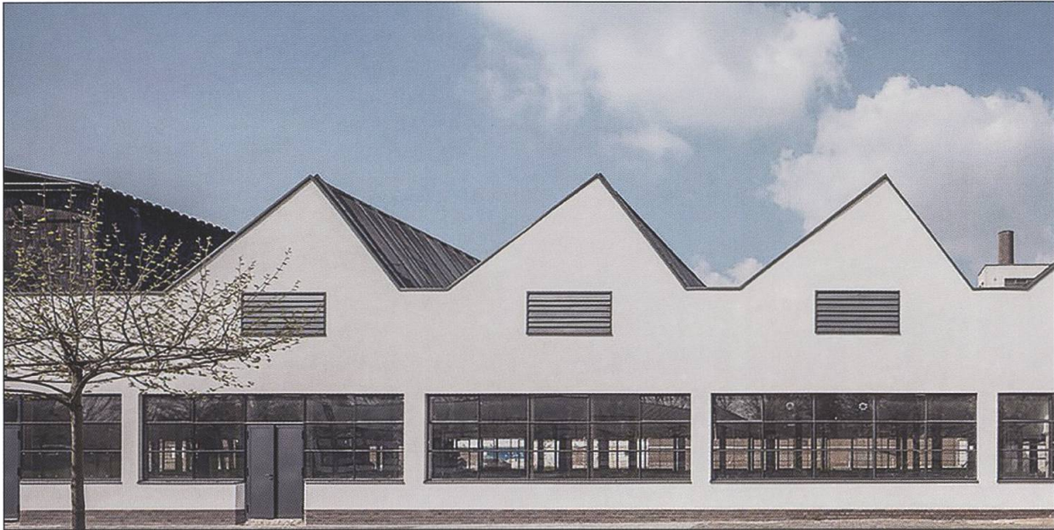
Abbildung 3. Die von Mies van der Rohe entworfene Produktionshalle der Vereinigten Seidenwebereien in Krefeld (Verseid AG) von 1931 mit Sheddach, ein Zeugnis des Neuen Bauens. Foto zVg.
