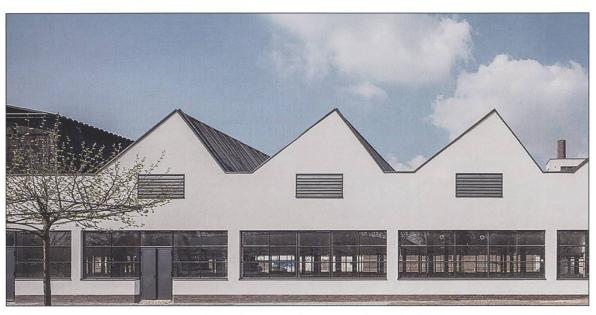
Abbildung 3. Die von Mies van der Robe entworfene Produktionshalle der Vereinigten Seidenwebereien in Krefeld (Verseid AG) von 1931 mit Sheddach, ein Zeugnis des Neuen Bauens. Foto zVg.
