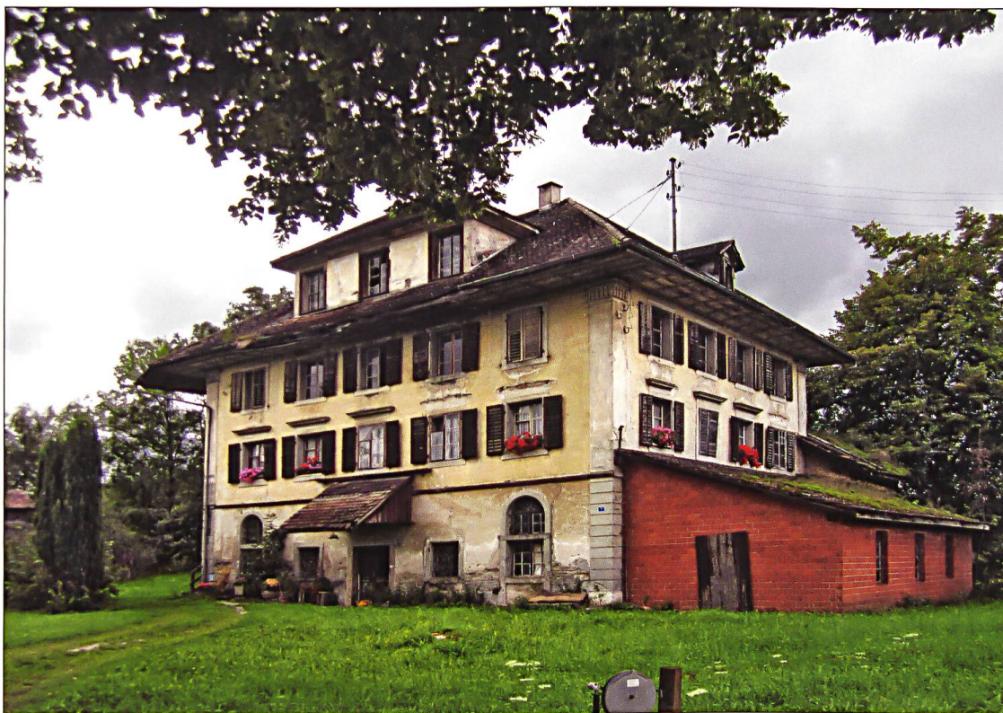
Die einstige Burgrainmühle, die später zu einem Elektrizitätswerk umgebaut wird, wird nach der geplanten Renovierung – zusammen mit der Sankt-Blasius-Kapelle – auf dem Landgut Burgrain zu einem baulichen Juwel.
