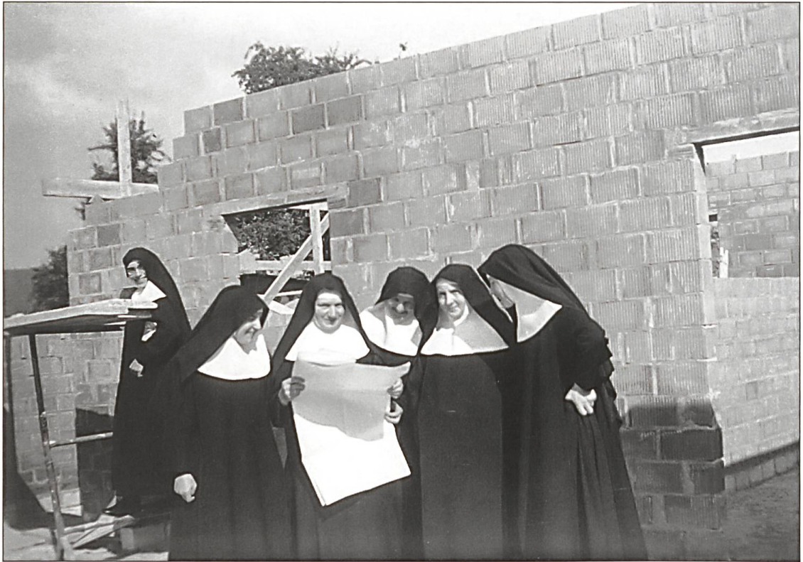
Schwestern studieren auf der Baustelle des Alters- und Pflegeheims den Bauplan.
