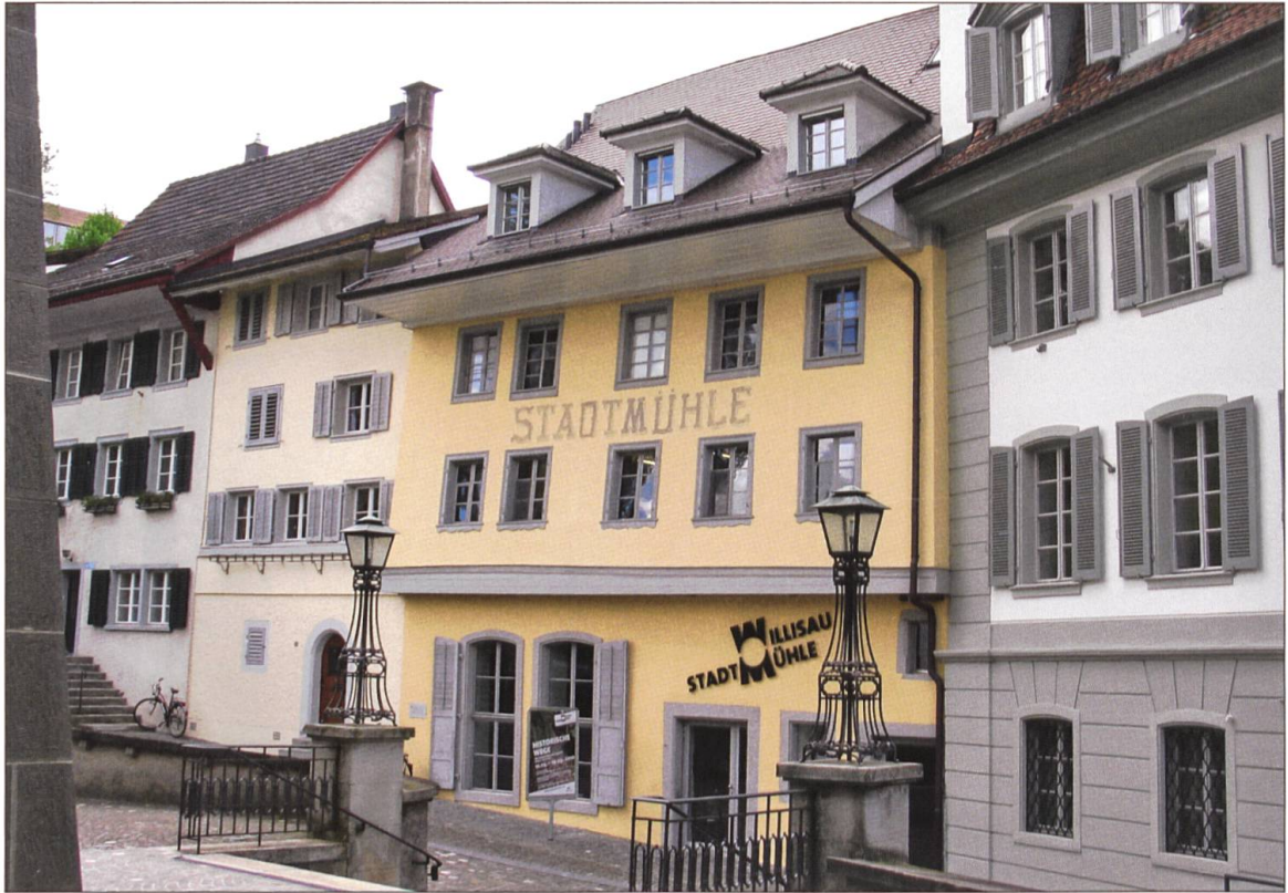
Die sorgfältig restaurierte Stadtmühle zwischen Sigristenhaus, Müllerhaus und Pfarrhaus.
