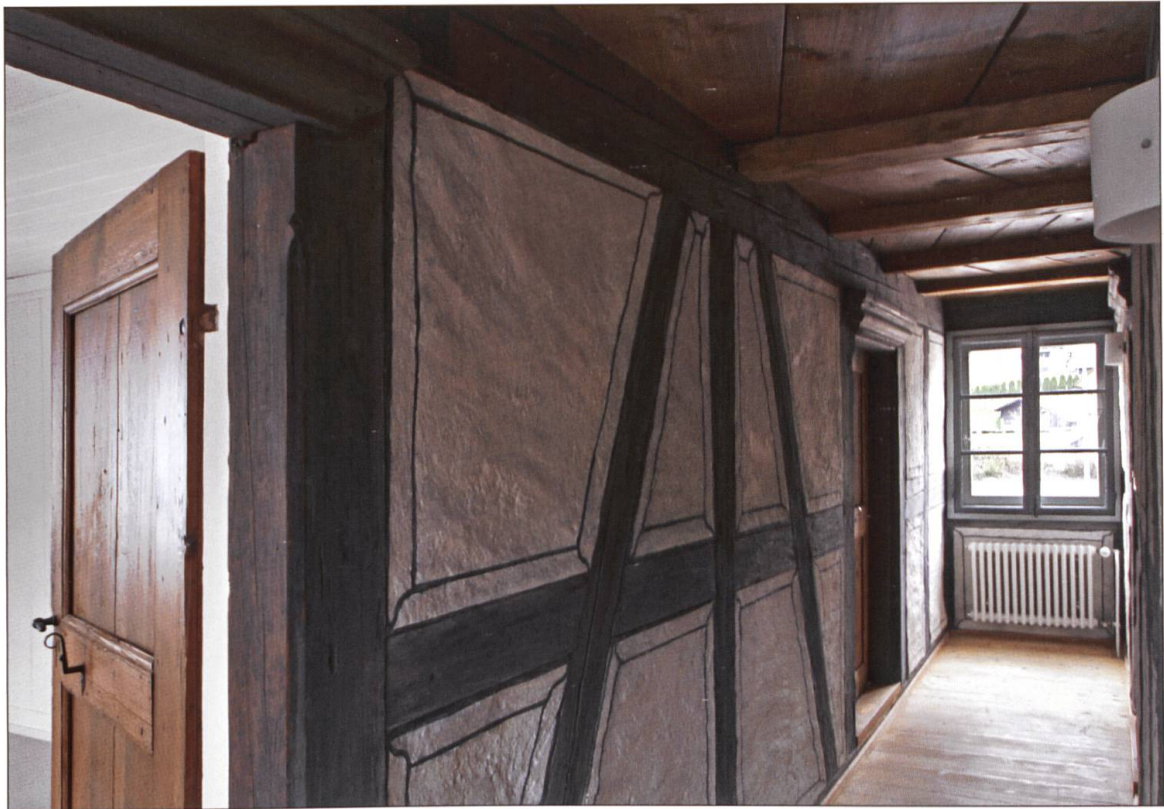
Innenansicht Sigristenhaus, zweites Obergeschoss, Blick in den Korridor mit den originalen bauzeitlichen, bemalten Riegelwänden nach der Gesamtrenovation.
