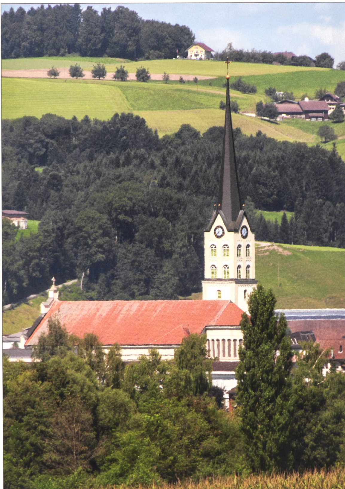
Kirchen prägen in der Schweiz die Dörfer und Städte. Die Kirche der Pfarrei Schötz-Obmstal befindet sich im Zentrum von Schötz und ist dem heiligen Mauritius geweiht. Sie wurde 1875–1879 im neuromanischen Stil errichtet. Foto Hermenegild Heuberger-Wiprächtiger
