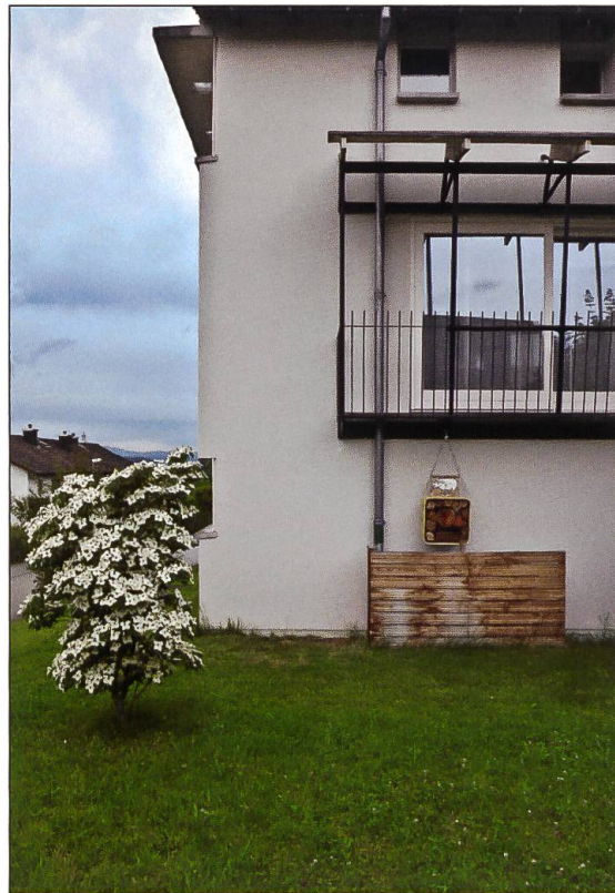
Farbigkeit der Fassade.
