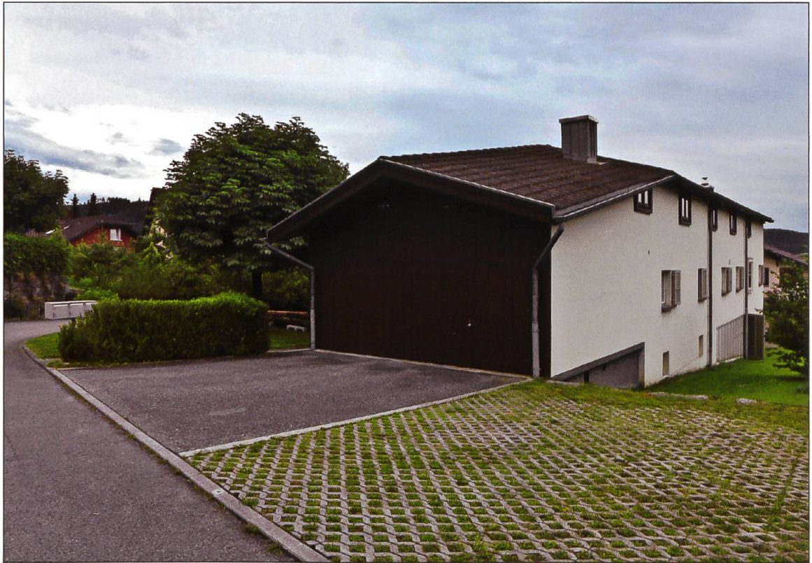
Einfahrtsbereich mit Nordfassade.
