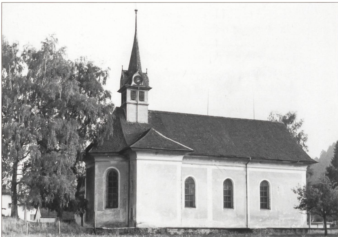
Alte Kirche Langnau, Ansicht von Norden, um 1970.
