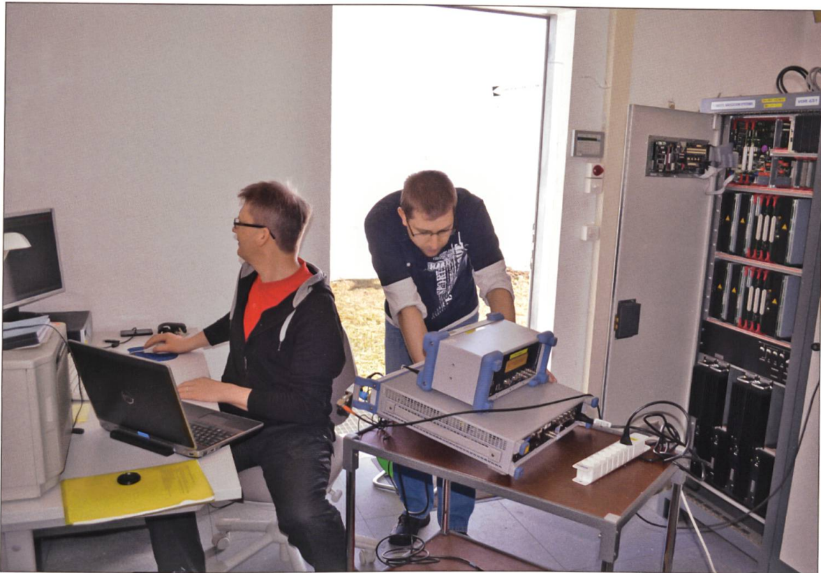
Viermal pro Jahr prüfen Techniker von Skyguide die Anlage auf Herz und Nieren.
