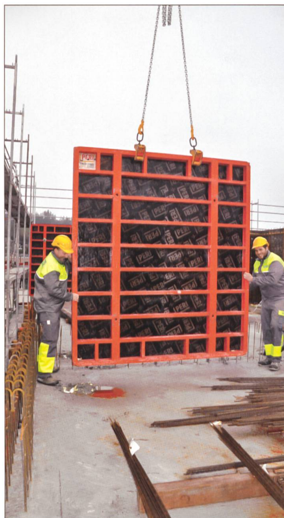
Links: Auf der Baustelle beim Hallenbad Willisau (1971) sind grosse Mengen von Schalmaterialien zum Reinigen bereitgelegt. Rechts: Grossflächenschalung auf dem Bauplatz Gerbi in Willisau im Jahr 2014.
