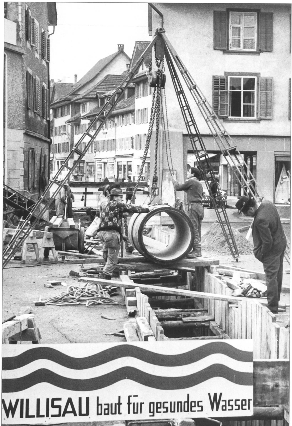
Verlegen von Kanalisationsrohren auf dem Postplatz Willisau, 1967.
