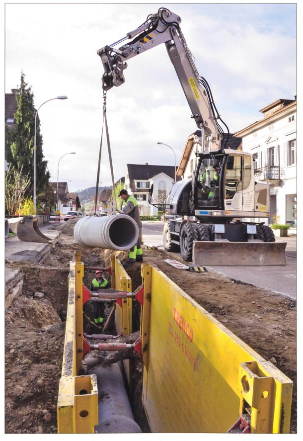
Die gleiche Arbeit mit dem Hydraulikbagger und einer Elementspriessung 2014 in Ettiswil.
