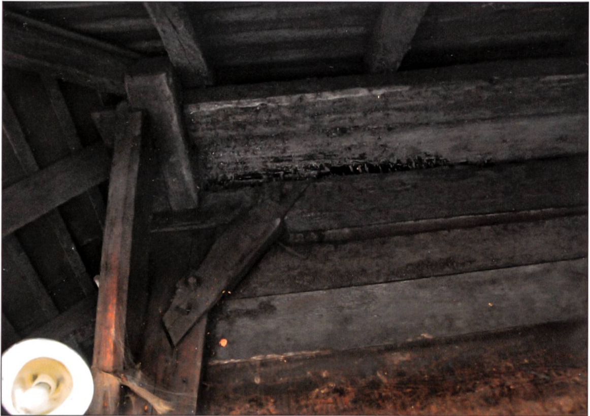
Dekorativ verblattetes und vernageltes Kopfband verstrebt den Eckständer mit dem Geschossrahm. Ausfachung mit zurückversetzten Bohlenbrettern.
