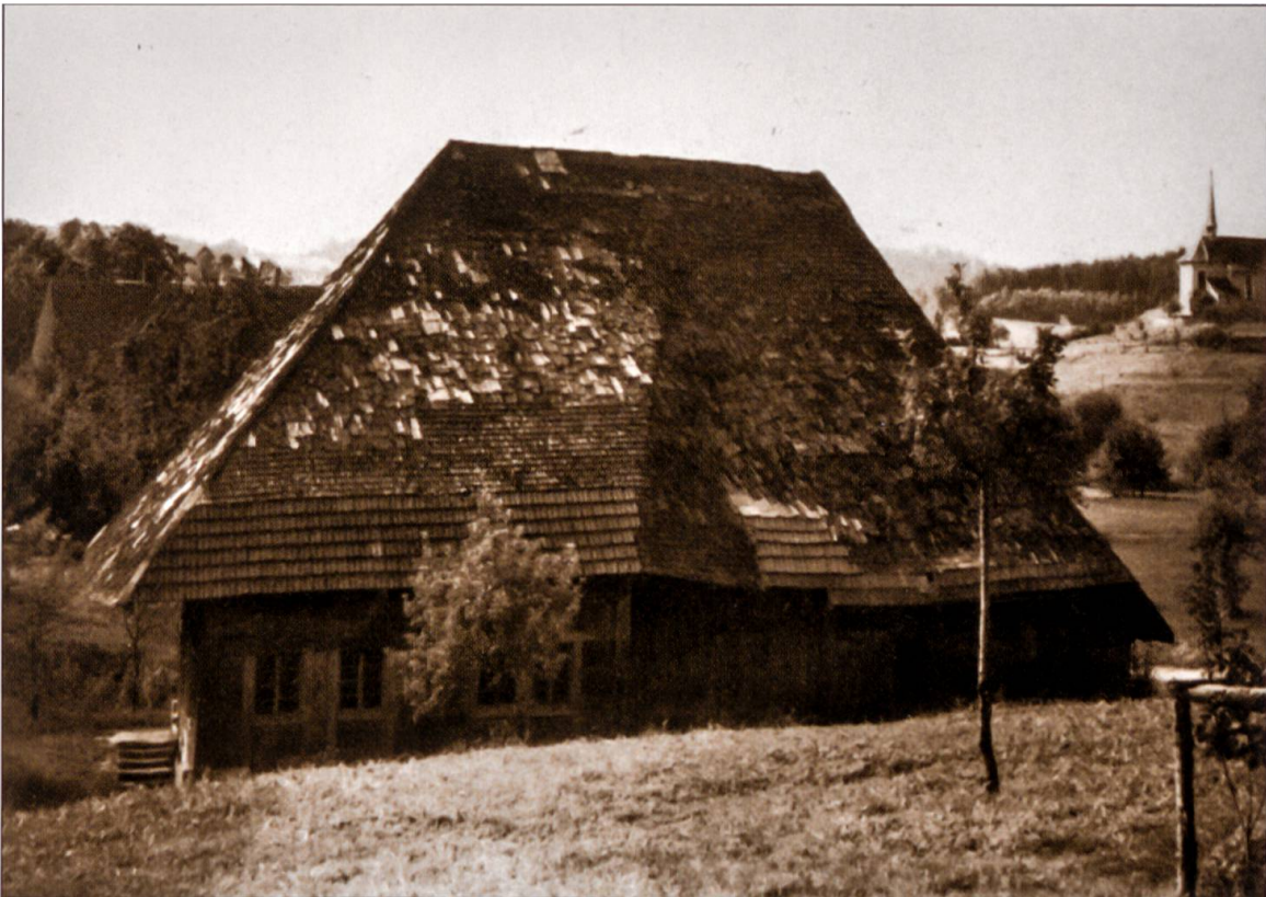
Typ 1 Beispiel Altbüron Wohngebäude, gekoppelt mit Stallscheune. Dieser Bautyp entspricht dem Rauchhaus Unterberg. Bildquelle Ernst Brunner
