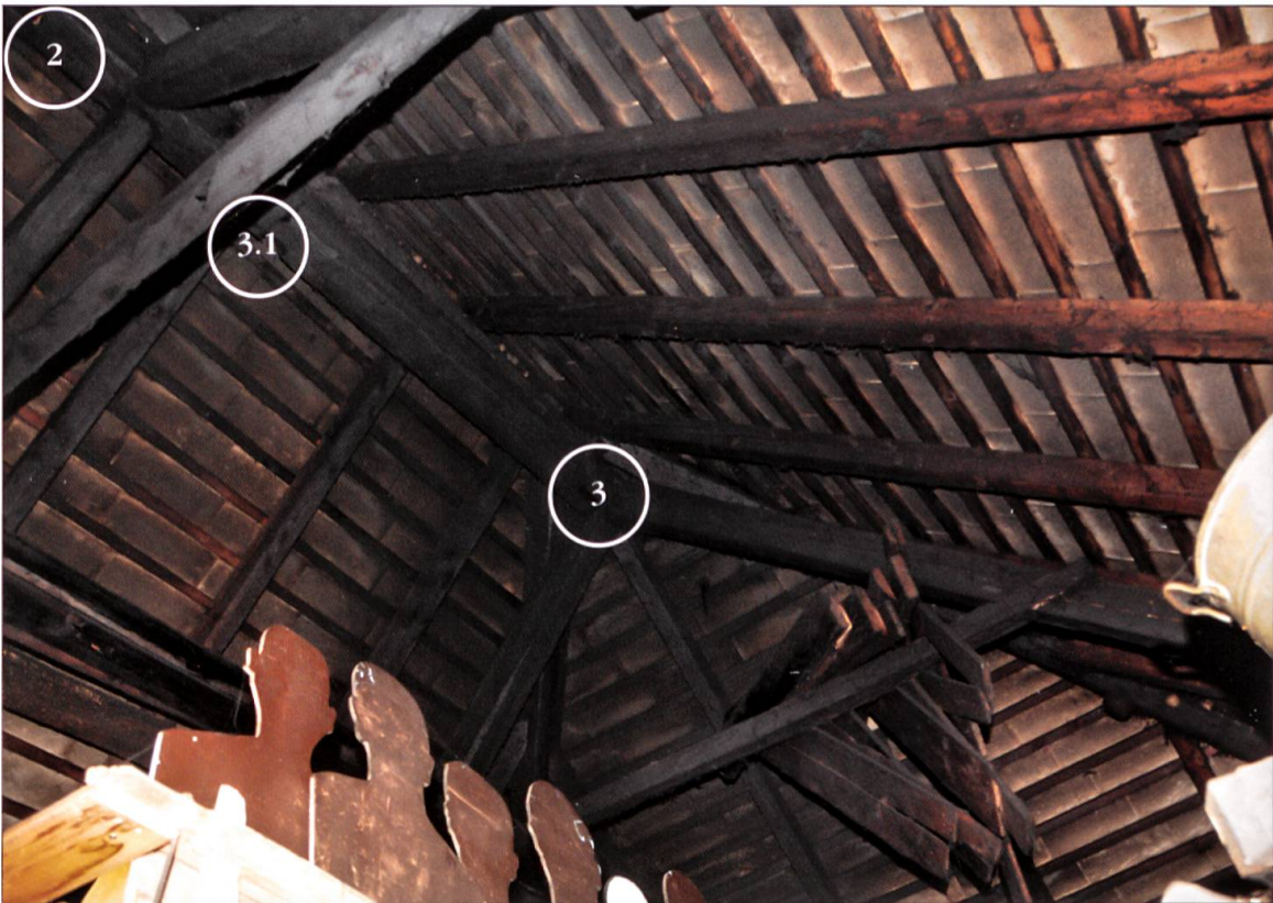
3.1 Firstverblattung Längsverstrebung zu Hochstud 3.
