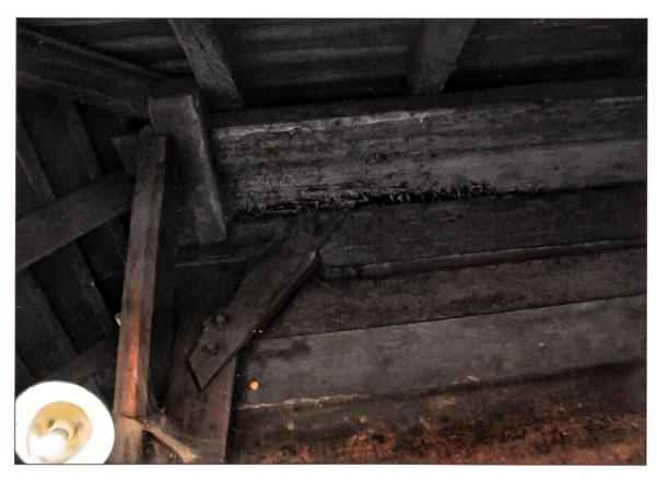
Dekorativ verblattetes und vernageltes Kopfband verstrebt den Eckständer mit dem Geschossrähm. Ausfachung mit zurückversetzten Bohlenbrettern.
