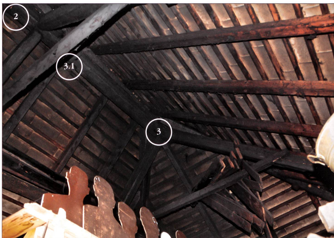
3.1 Firstverblattung Längsverstrebung zu Hochstud 3.
