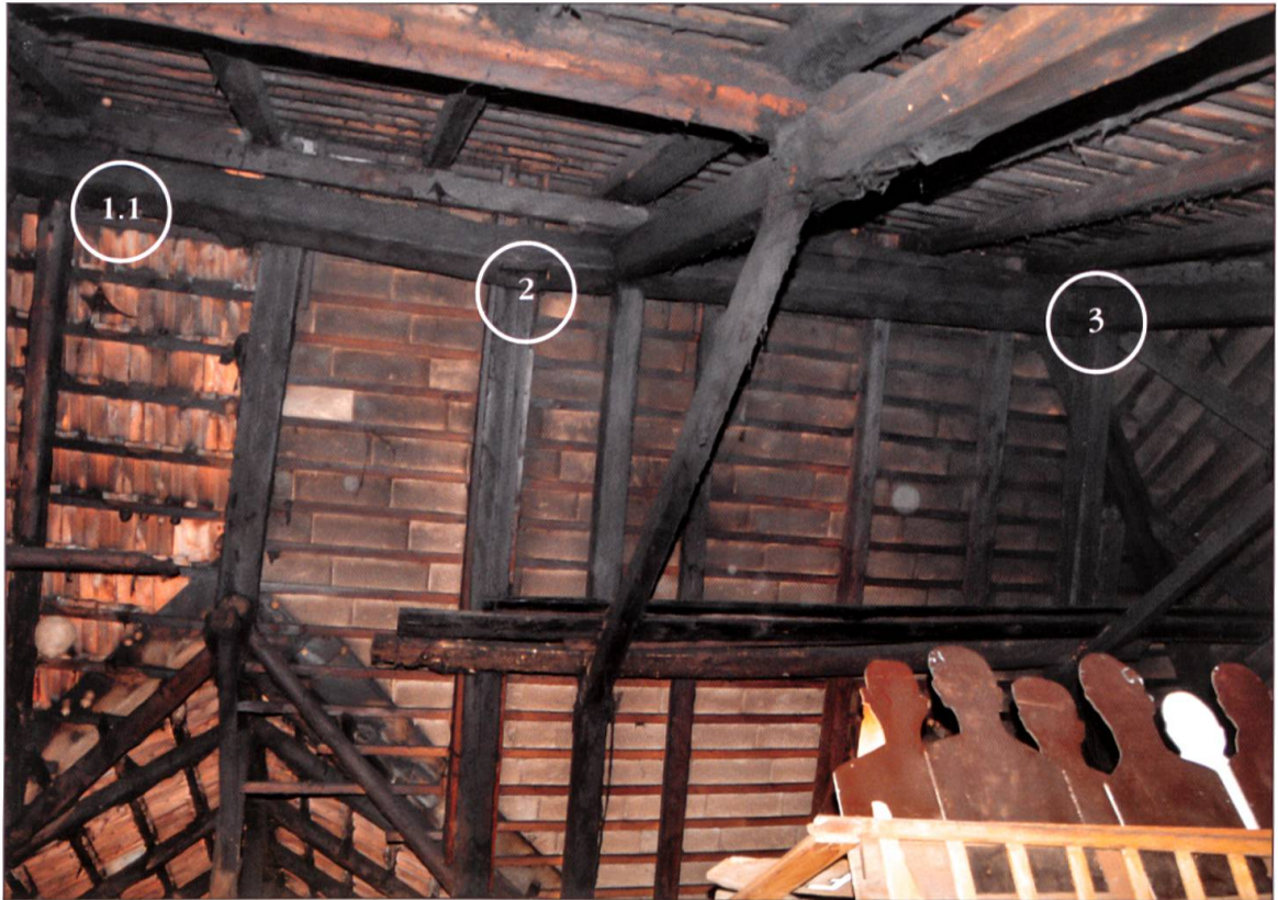
Lochbefunde an Hochstud-Firstpfette: (siehe Schema Abb. 180/181, Seite 57)
