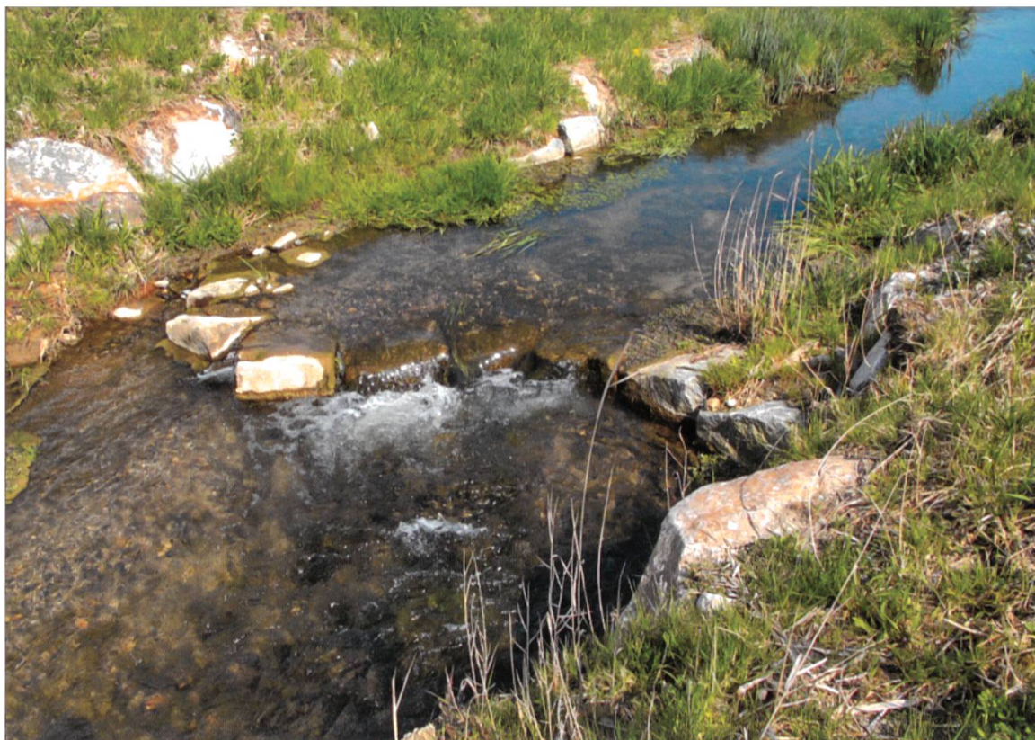
Bachbuhnen stabilisieren die Sohlenhöhe und lenken die Strömung.
