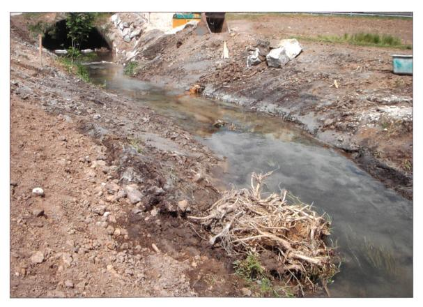
Wurzelstöcke eignen sich gut zur Böschungssicherung und zur Strömungslenkung. Foto Edi Gassmann t+p
