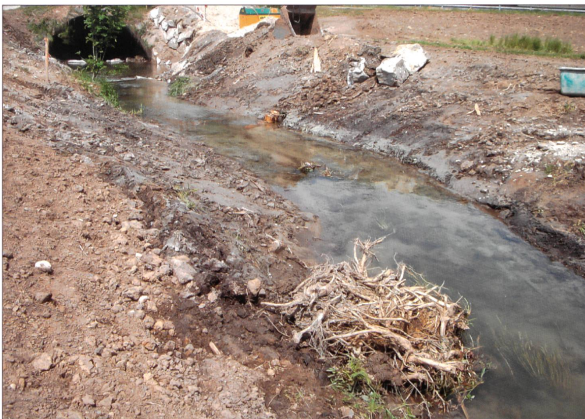
Wurzelstöcke eignen sich gut zur Böschungssicherung und zur Strömungslenkung.
