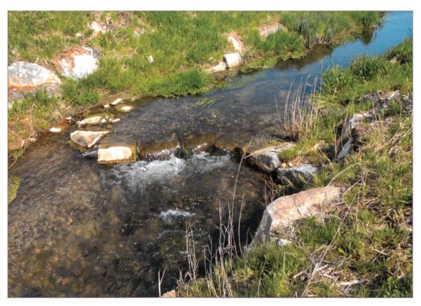
Bachbuhnen stabilisieren die Sohlenhöhe und lenken die Strömung.
