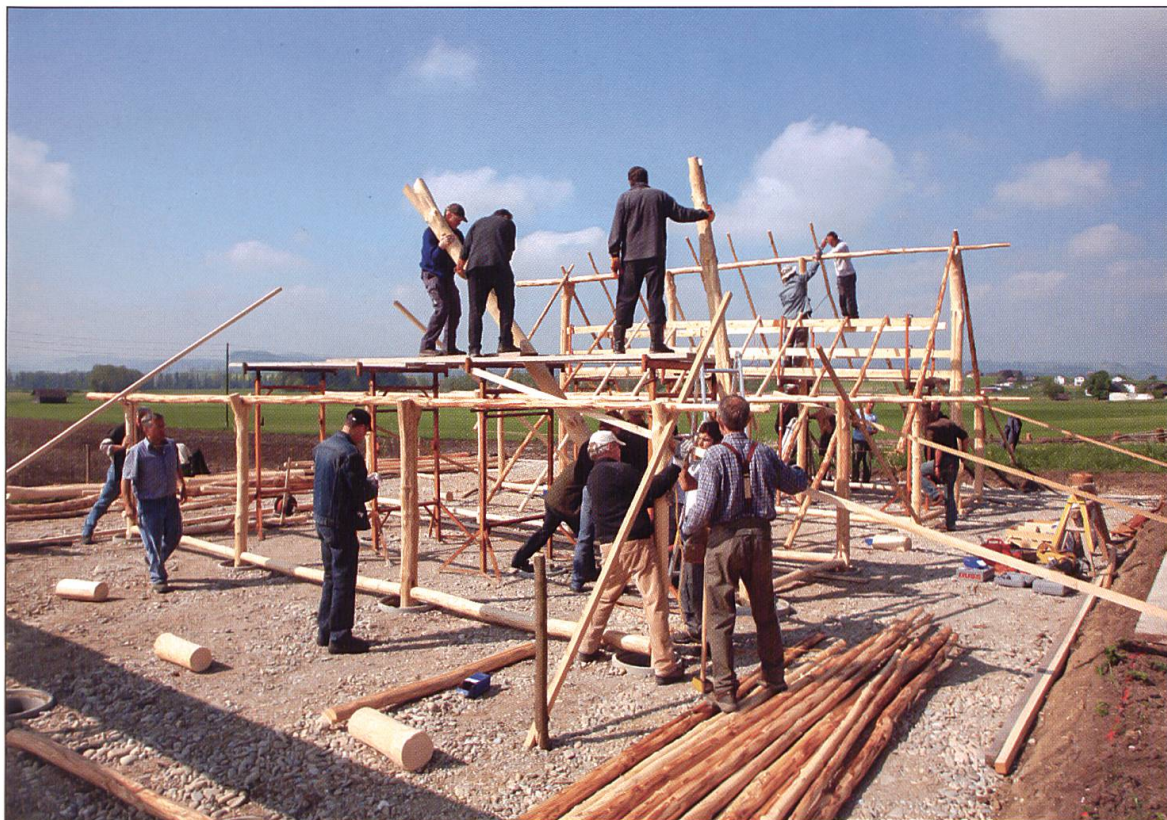
Aufrichten der Rohbauten.
