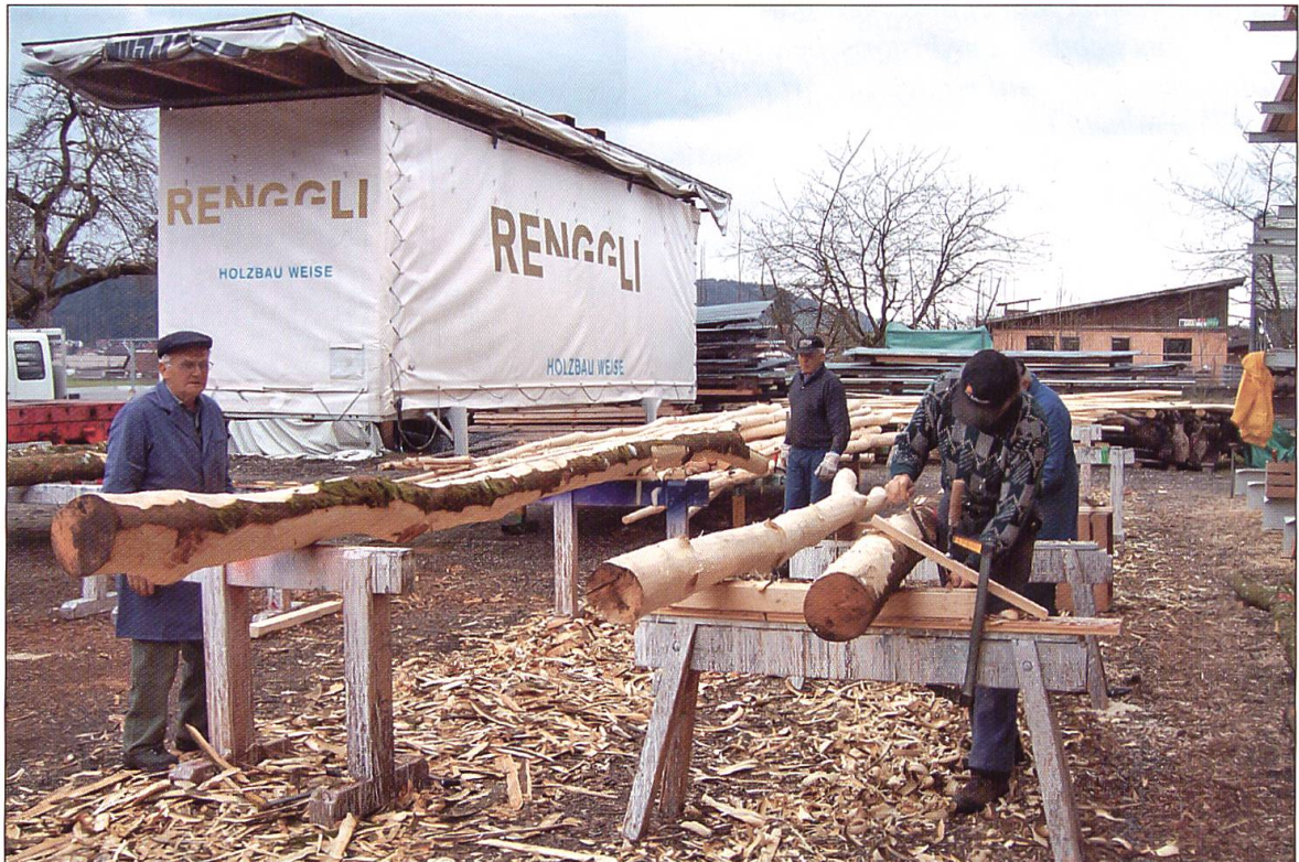
Zurichten des Bauholzes im Holzbauwerk der Firma Renggli, Schötz.
