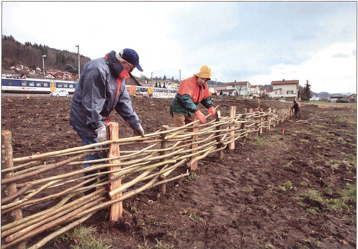
Erstellen des Flechtwerkzauns um die Siedlung.
