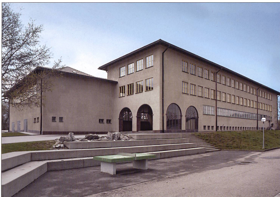
Ansicht der nordwestlichen Eingangsfront der Schulanlage. Aufnahme nach der Restaurierung 2006.
