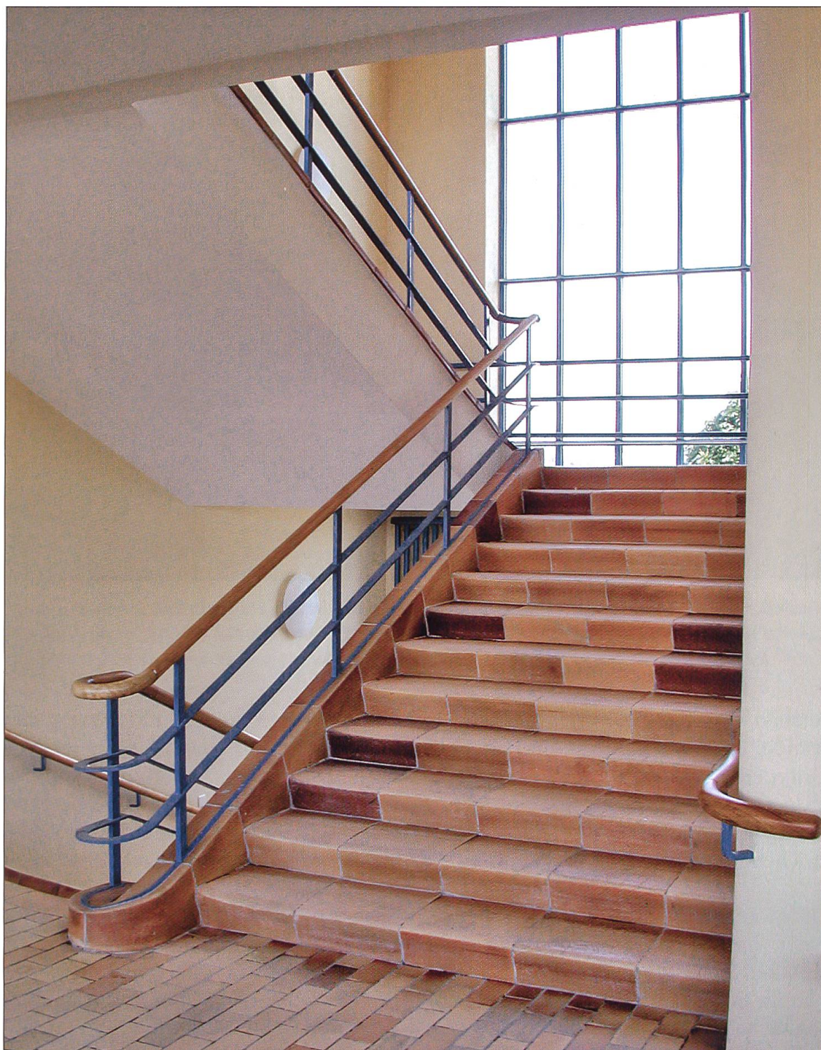
Ansicht des Treppenhauses. Zustand nach der Restaurierung, in der originalen Farbgestaltung. Aufnahme 2006.
