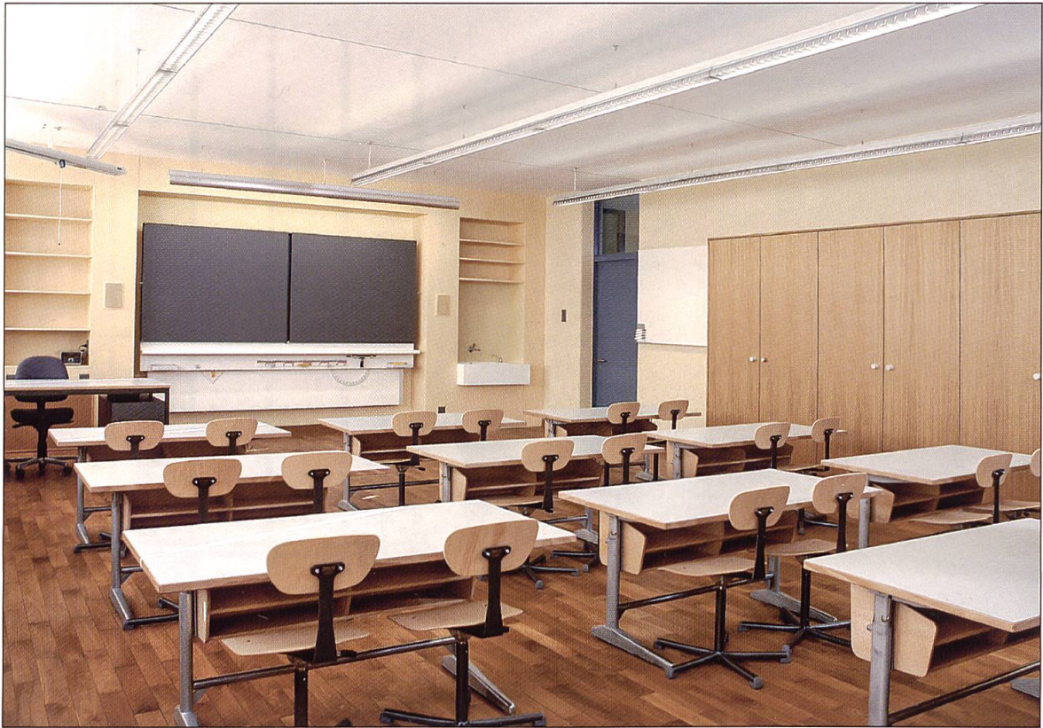
Klassenzimmer mit originalem Eichenparkett, Wänden in den Pastellfarbtönen und mit neuem Vorbau für die technischen Installationen im Bereich der Wandtafel. Aufnahme nach der Restaurierung 2006.
