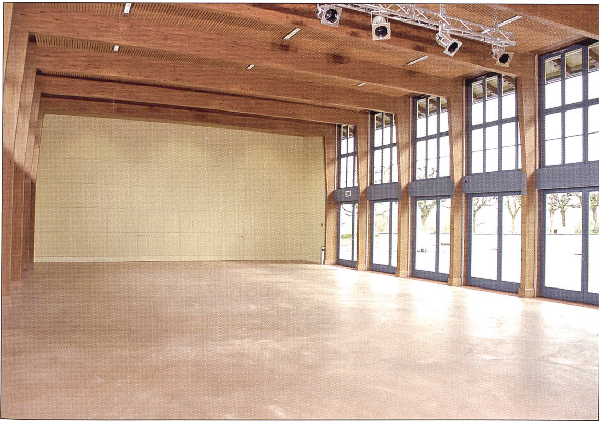
Innenansicht der ehemaligen Turnhalle, die neu als Mehrzweckraum genutzt wird. Gut sichtbar sind die Gestaltungselemente der Wandpfeiler und Unterzüge aus Holz und die verglasten Türen, die den Bezug zum Spiel- und Pausenplatz schaffen.
