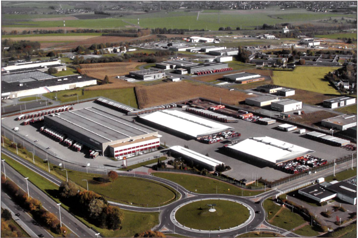
Die 1992 im Zuge der Internationalisierung des Geschäftes erbaute belgische Niederlassung Milmort wurde 2003 mit einem grossen Logistik Center erweitert.
