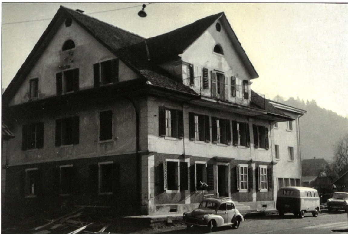
Die 1836 erbaute Pinte in Adelboden kurz vor dem Abbruch 1963.
