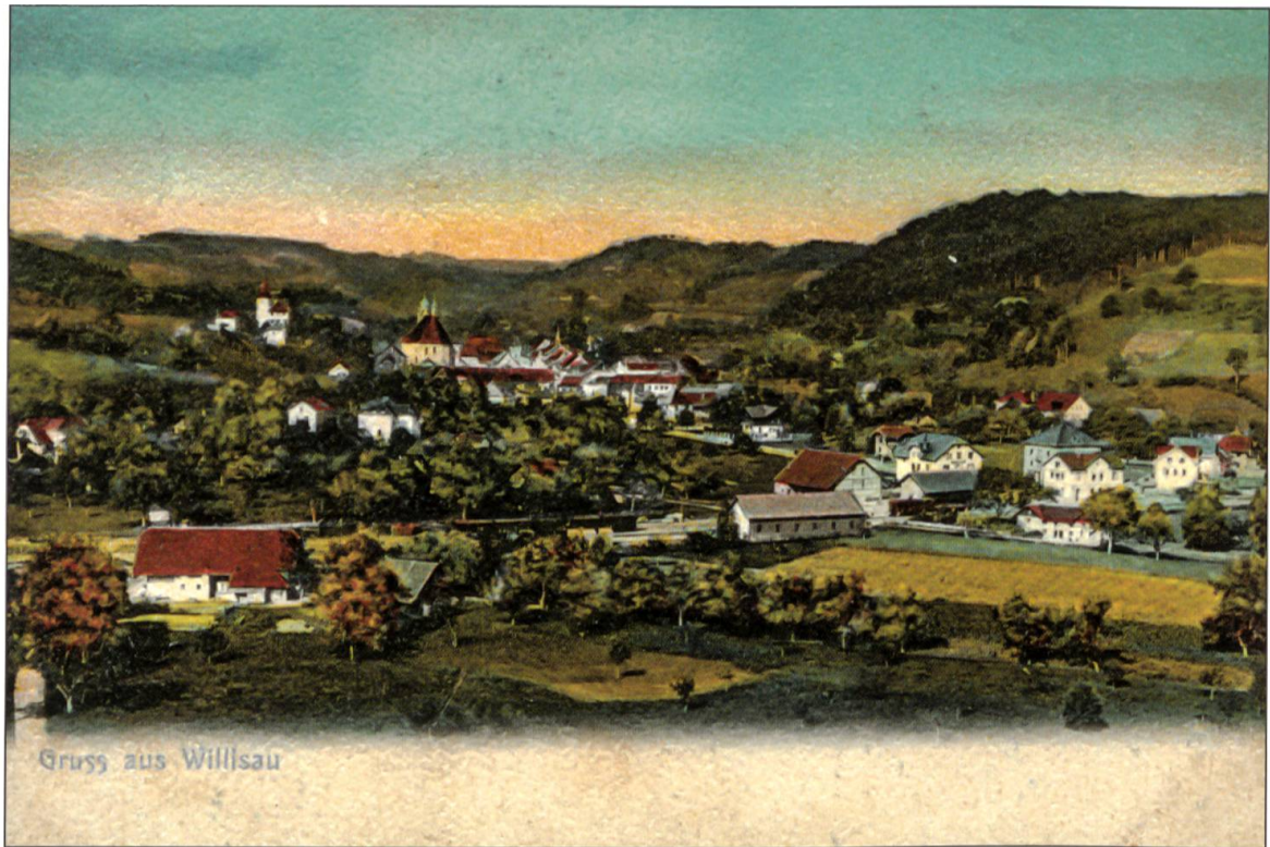
Willisau, Bahnhofareal 1907. Das Städtchen Willisau hat noch keine Industrie. Der Bahnhof liegt ausserhalb des Stadtkerns. Historisches Archiv Willisau
