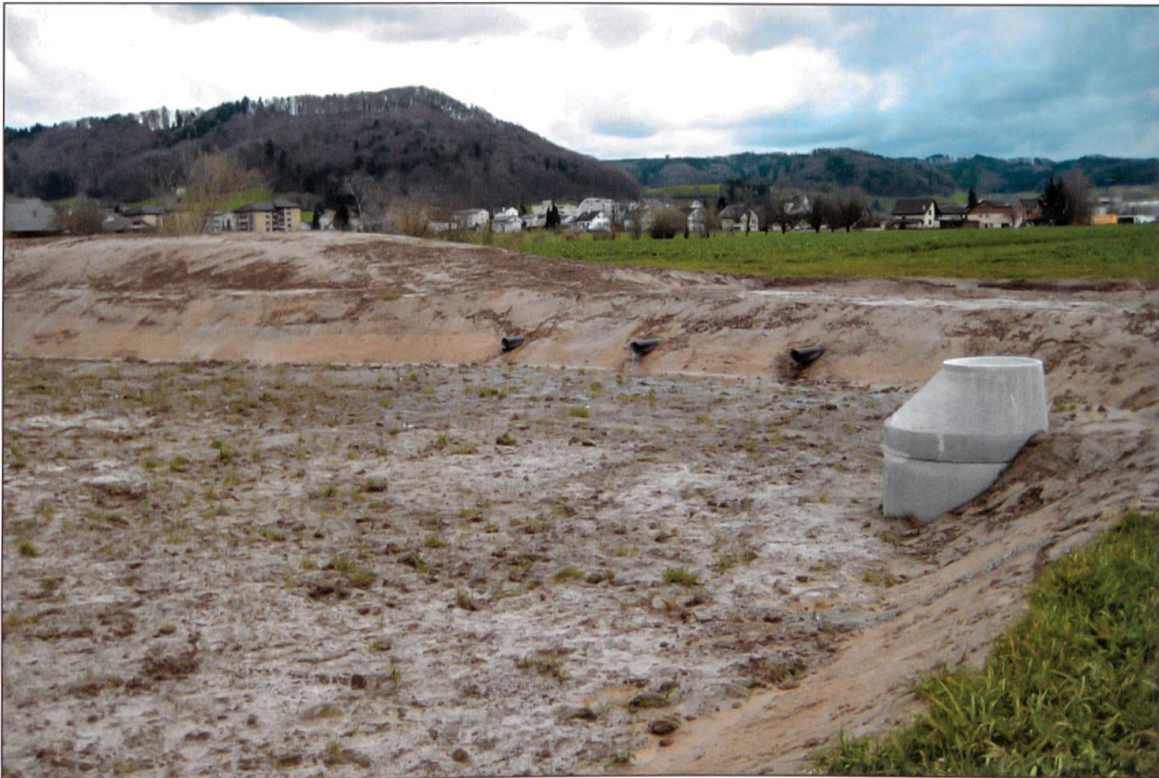
Versickerungsbecken im Bau.
