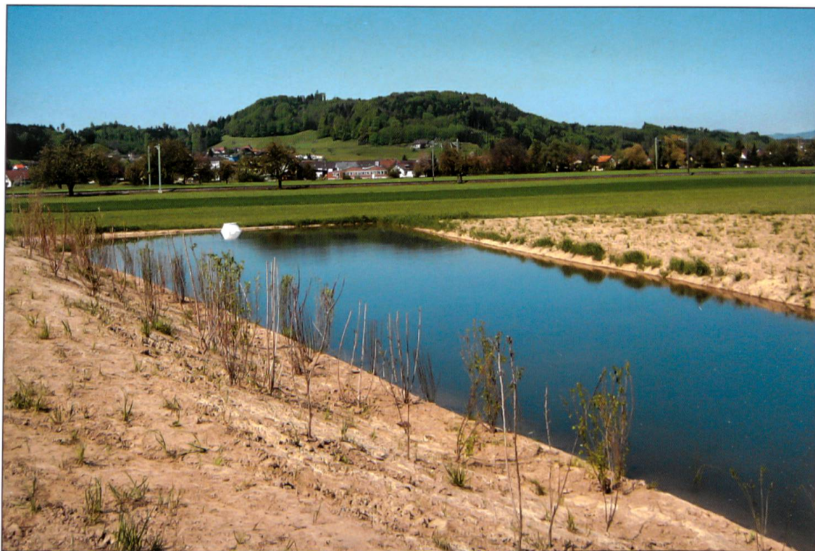
Versickerungsbecken in Betrieb.
