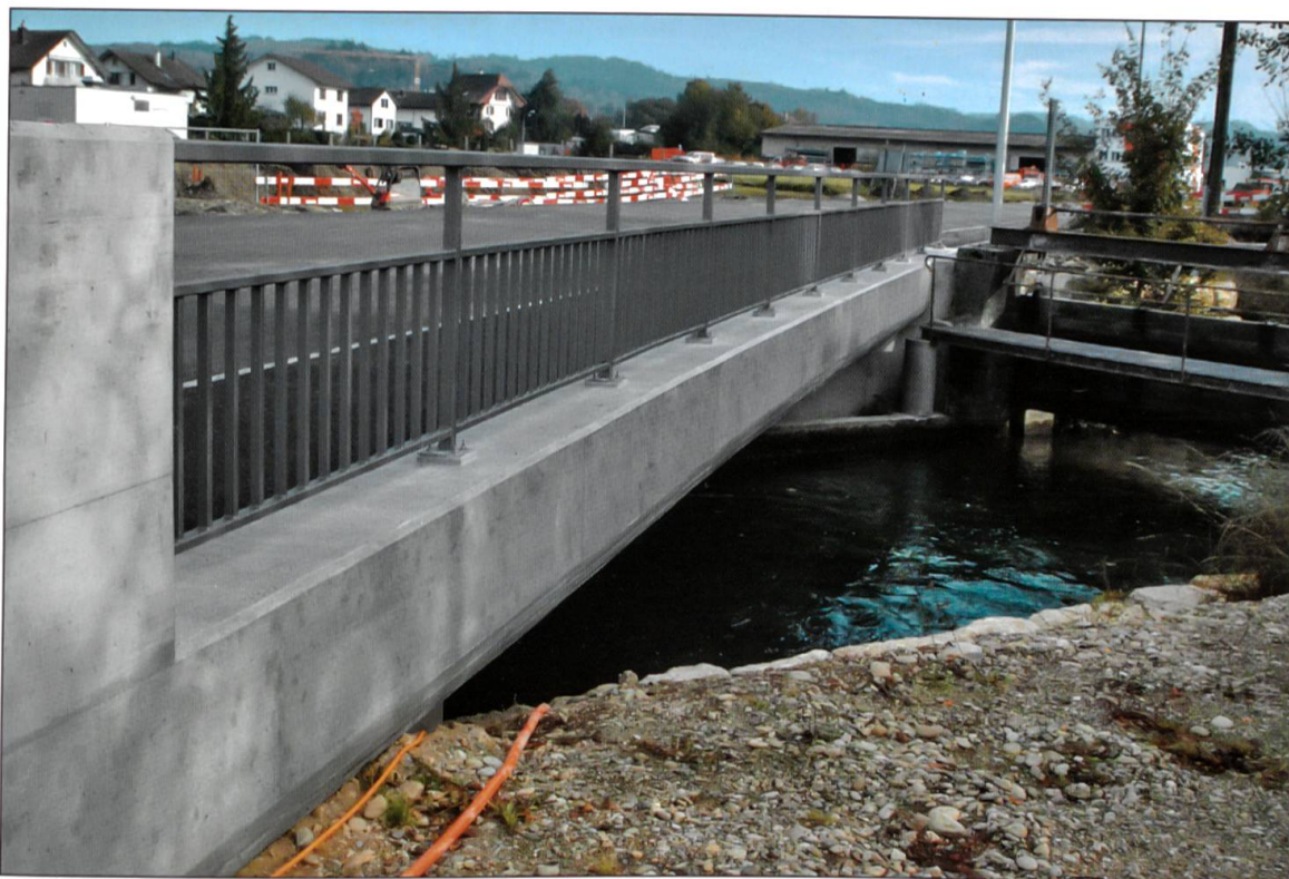
Die neue Tychbrücke im Aeschwubr.
