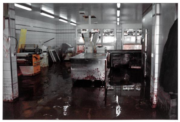
Ansicht des Produktionsraumes in der Bäckerei, wo das Wasser 1992 einen Höchststand von einem Meter erreichte. Durch den hohen Wasserstand wurden alle Maschinen, die Kühl- und Tiefkühlräume sowie der Unterlagsboden für drei Monate unbrauchbar (Revisionen und Austrocknung).
