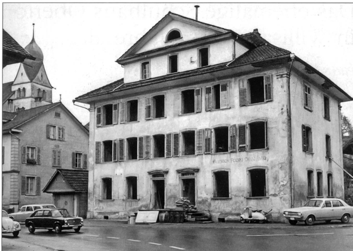
Das alte Landschulhaus kurz vor dem Abbruch 1971.
