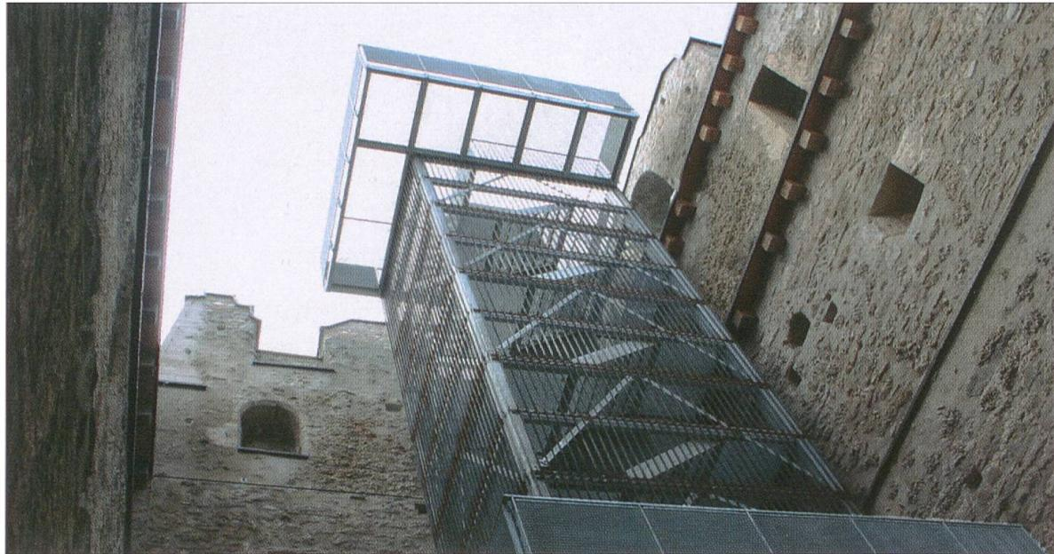
sucher. Der Treppenturm ist ein einheitlich wohlgestaltetes Bauwerk und erfüllt seinen Zweck im geschichtlich eindrücklichen Baukörper des Wohnturmes aufs Beste. Wesentlich ist sein selbstständiges Fundament, auf dem die 39 t Gesamtgewicht ruhen. Damit ist die Rücksichtnahme auf die historische Bausubstanz gewahrt.
