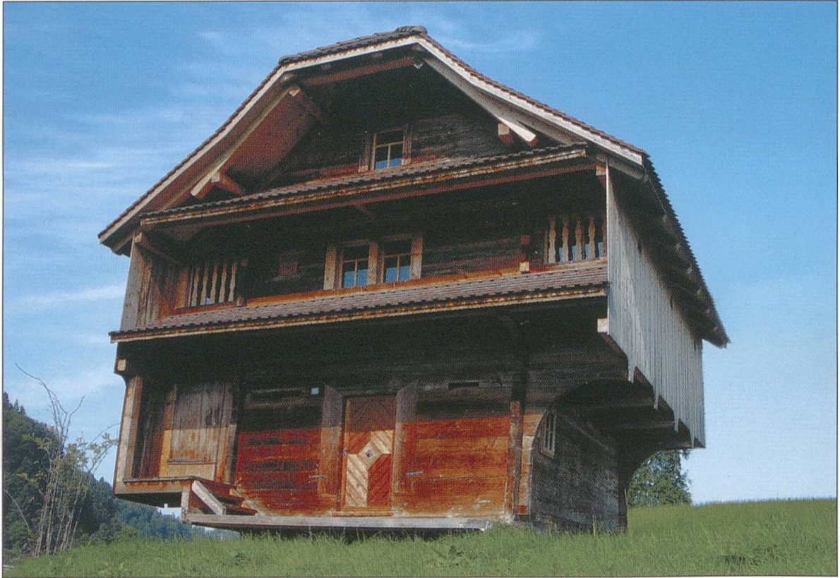
Renovierte Aussenansicht des Speichers Elsenau, erbaut im Jahre 1668.
