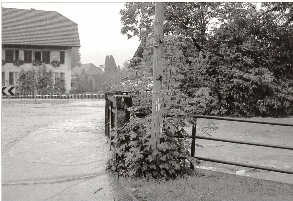
Brücke über die Wigger an der Strählgasse. Sie wurde beim verheerenden Hochwasser zum «Nadelöhr» und verursachte die Überschwemmung in Brittnau.
