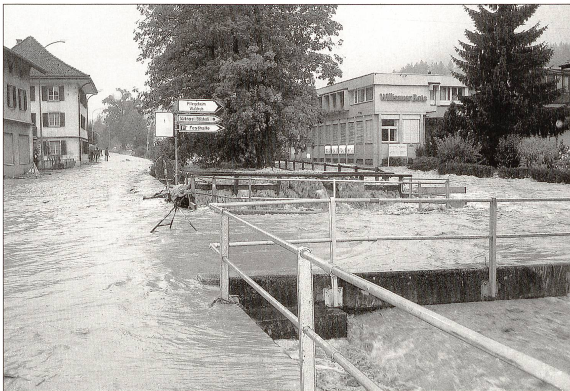
Der Fussgängersteg und die Brücke beim «Lustgarten» erwiesen sich wie 1988 als ein Hindernis und brachten die Enziwigger zum Überlaufen. Foto: Andy Schaller, Willisau
