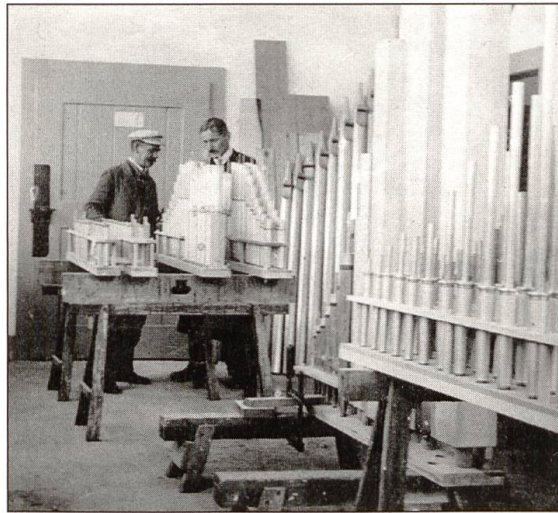
Blick in die Orgelbauwerkstatt. Einrastrieren (Einpassen) von Pfeifen in der Orgelbau AG Willisau, rechts der Orgelbauer Kilian Fischer (Foto undatiert).
