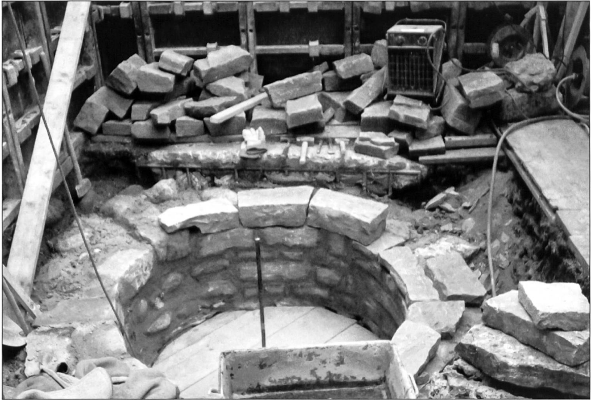
Der oberste Teil des Brunnens wird neu aufgemauert.
