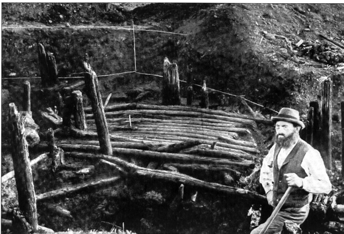
Johannes Meyer mit dem freigelegten Boden eines Hauses im jungsteinzeitlichen Dorf Egolzwil III. Die Grabung wurde im Auftrag des noch jungen Landesmuseums in Zürich durchgeführt und führte zu einer grossen Zahl neuer Erkenntnisse.
