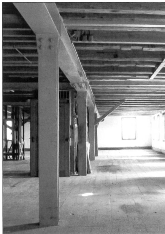
Stahlstütze und Balken im Produktionsbereich.
