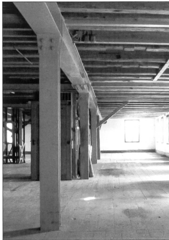
Stahlstütze und Balken im Produktionsbereich.
