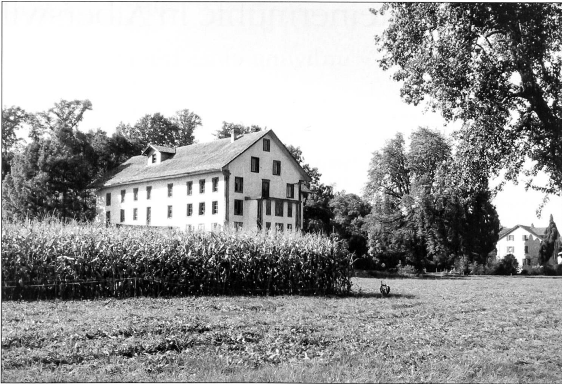
Neue Steinermühle, Südostansicht.
