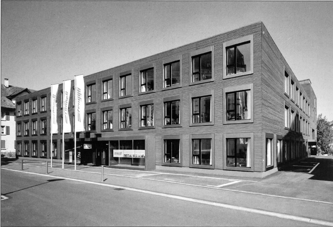
Wohn- und Geschäftshaus Renggli, Sursee. Baujahr: 2002. Bauberschaft: St.-Georg-Immobilien AG, Sursee. Architektur: Scheitlin-Syfrig & Partner Architekten AG, Luzern.
