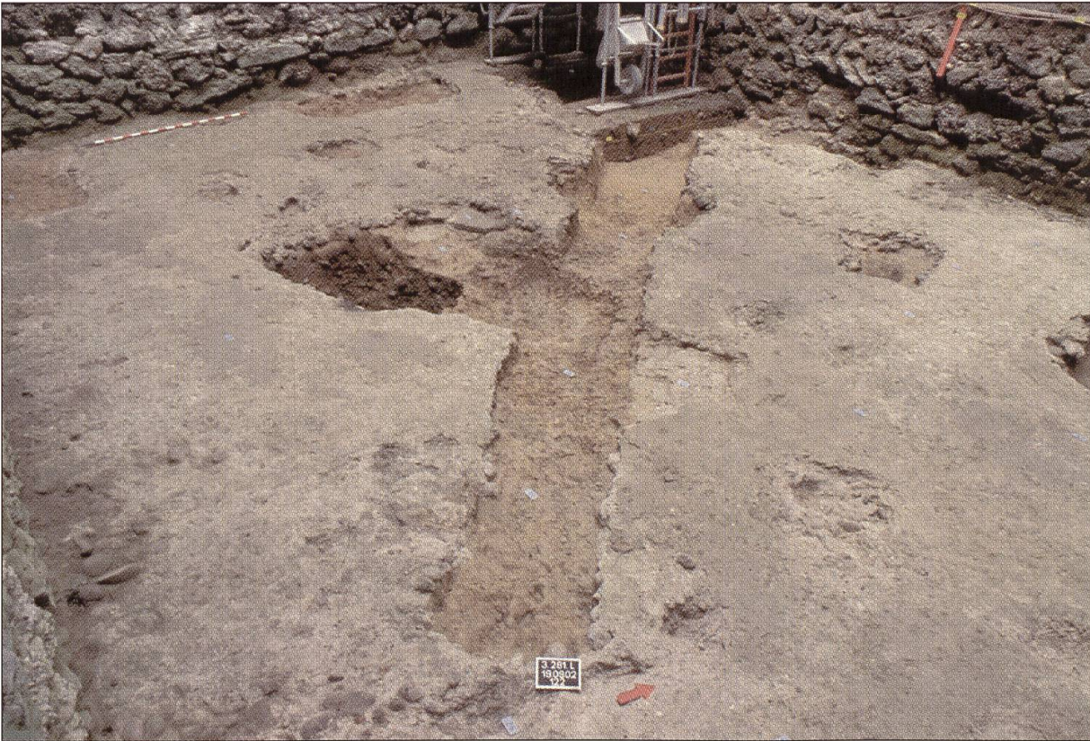
Im Mörtelboden, der den ganzen Keller des Burgturms Kastelen bedeckt, zeichnen sich die von Schatzgräbern angelegten Sondiergräben deutlich ab. Blick aus südöstlicher Richtung.
