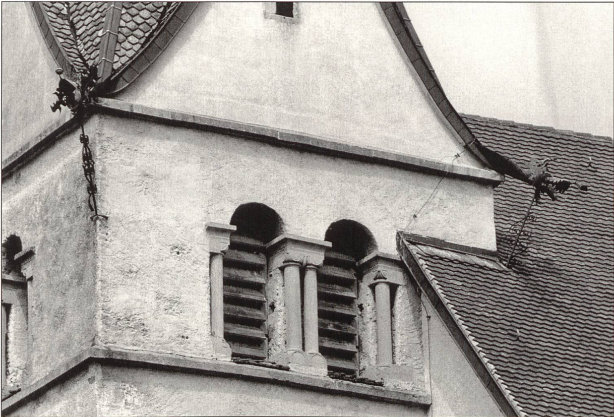
Abbildung 6: Das «romanische» Fenster in der Südmauer des nach dem Brand von 1647 erhöhten Turmes. Die Basis ist mit 1648 datiert.
