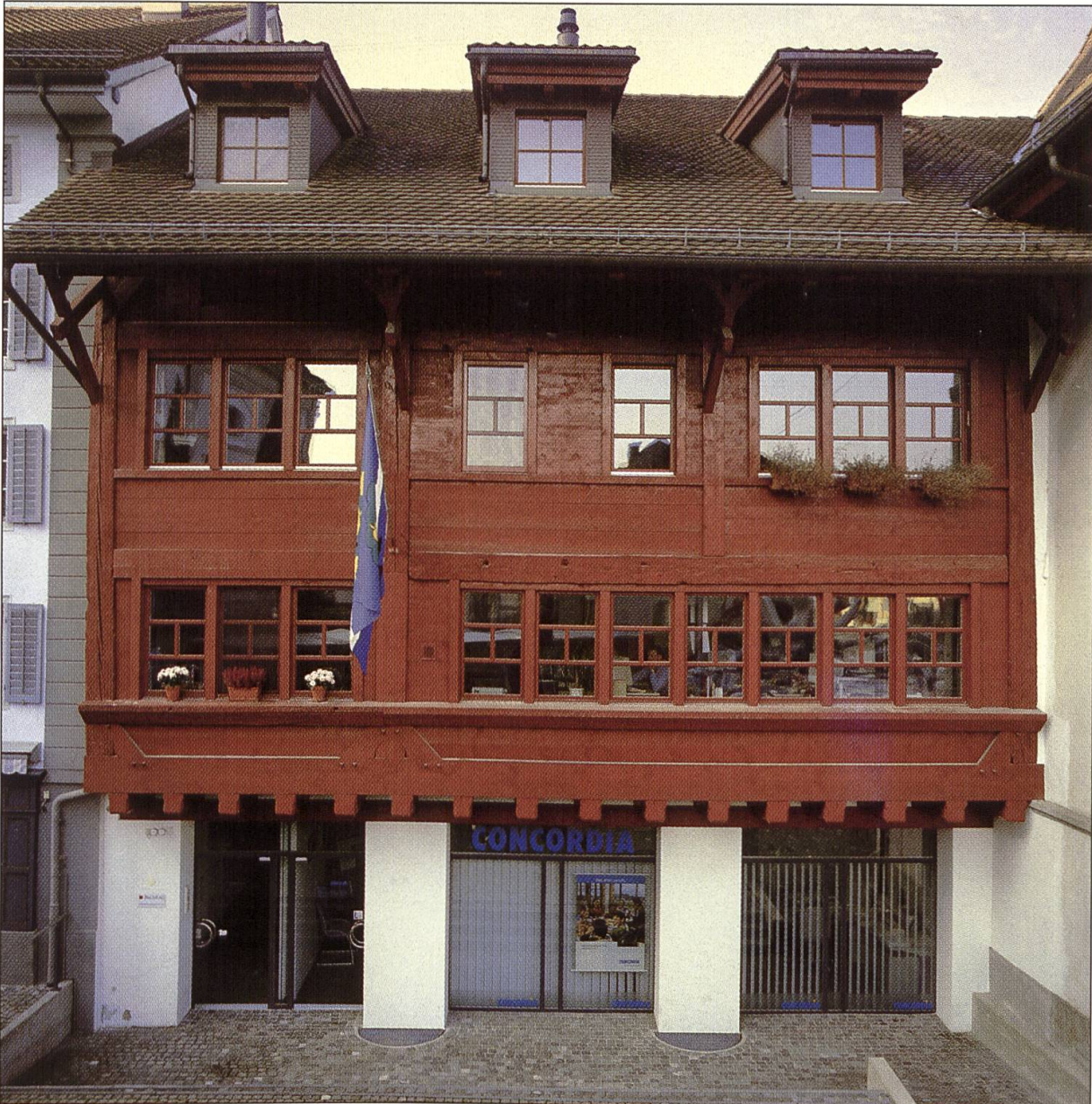
Abbildung 16: Das restaurierte Haus Müligass 2 von 1471/72.
