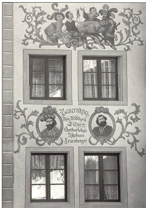
Abbildung 20: Ostfassade des Hauses Ober- tor 2 (Wirtschaft Zum Sternen). In den Medaillons sind Christian Schibi und Nikolaus Leuenberger, Anführer im Bauernkrieg von 1653, dargestellt. Gemalt von Hans Bachmann, Reiden, um 1896 (um 1930 übermalt und 2000 restauriert).
