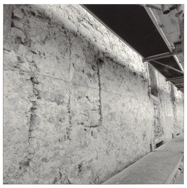
Abbildung 14: Westfassade des Hauses Obertor 2 (Wirtschaft Zum Sternen), das gegen die westliche Wehrmauer gelehnt ist. Zehn Meter über dem Boden, im Bereich der Fenster des dritten Obergeschosses, haben sich noch Zinnen der Wehrmauer erhalten, die ursprünglich offen waren und durch die der angreifende Feind beschossen werden konnte.
