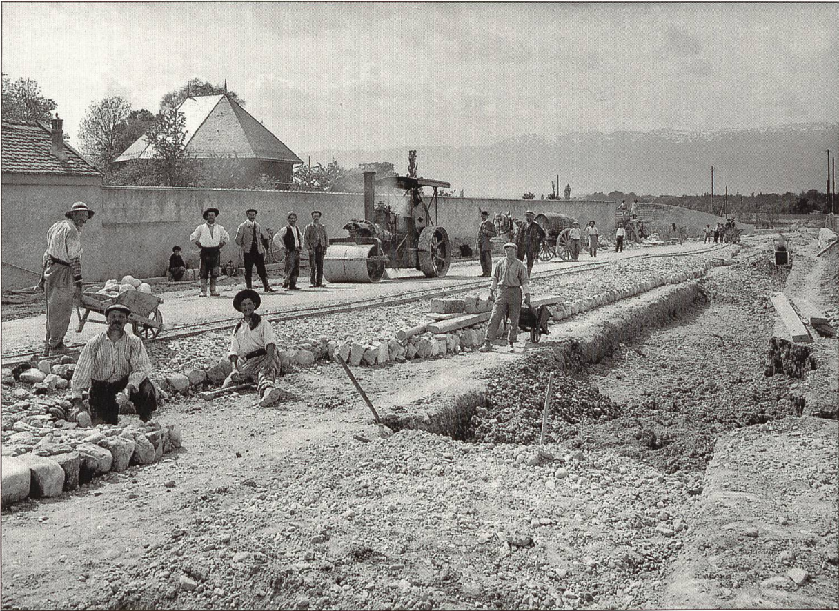
Abbildung 5: Bau einer Chaussee nach altem Handwerk, 1912, an einer Strasse in Genf. Strassenarbeiter setzen in minutiöser Kleinarbeit das massive Steinbett zusammen, das später mit gegen oben feiner werdendem Schotter verfüllt, verdichtet und durch den Auftrag von Grien zu einer gewölbten Fahrbahn ausgestaltet wird. Nur die Dampfwalze fehlte beim Bau der neuen Baselstrasse... Foto: Centre d'iconographie genevoise
