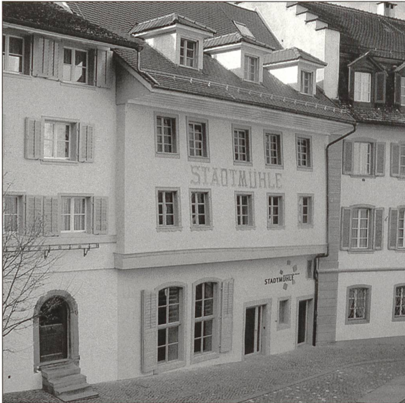
Ostseite der Stadtmühle nach der Renovation.
