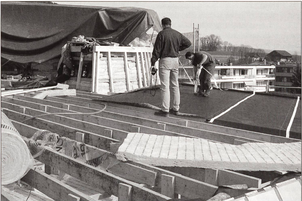
Bild unten: Aufbringen der Wärmedämmung und Unterdachbahn von Ebene zwei.
