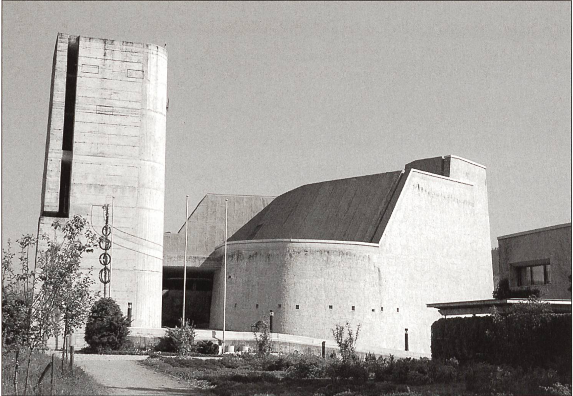
Zustand vor der Renovation ...
