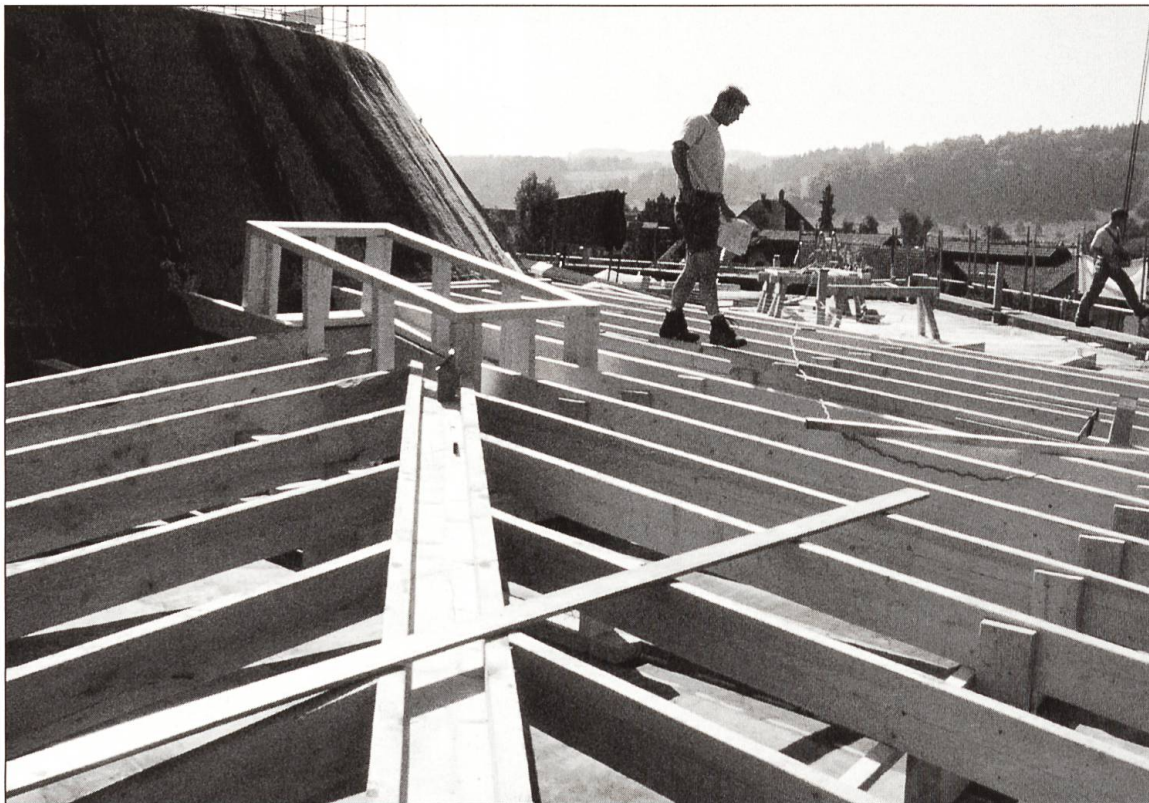
Bild oben: Die Tragkonstruktion ist im Holzbau gehalten (Ebene eins mit Verlängerungsbauten Lichtschalen).
