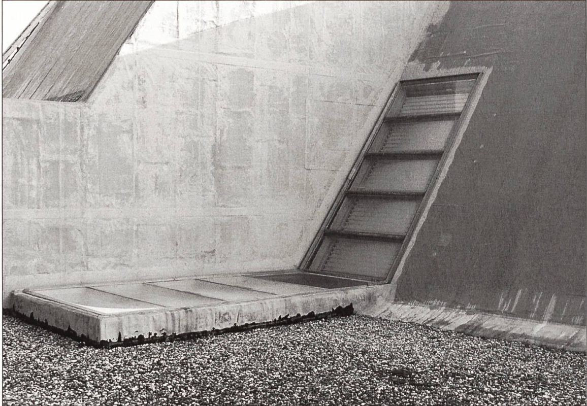
Detailansicht des Kirchendaches (Oberlicht und Betonvordach) vor der Renovation.
