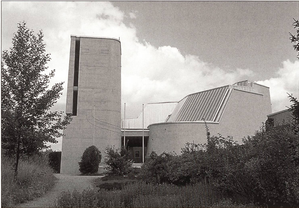
... und nach der Renovation.
