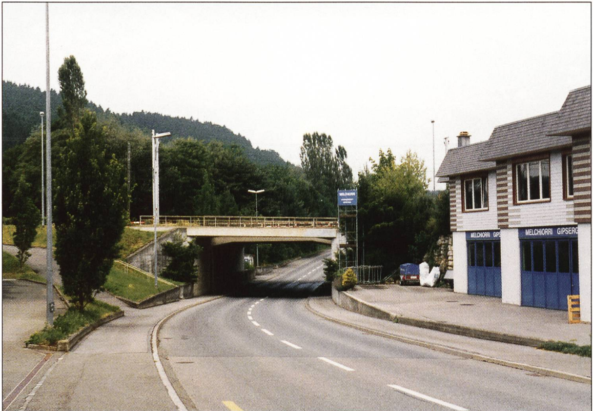
Die Unterführung der Langnauerstrasse unter der SBB-Linie.
