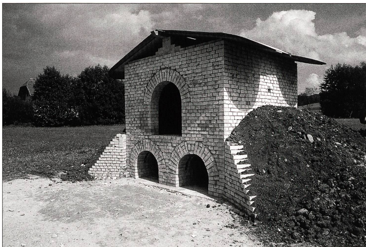
Abbildung 4: Der für das Experiment beim ehemaligen Kloster St. Urban nach mittelalterlichen Vorbildern erbaute zweizügige, oben offene Kammerofen.
