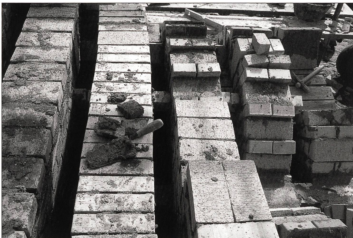
Abbildung 6: Der Kammerofen während des Baus. Blick auf den Herd. Rechts im Bild sind die Zwickel zwischen den das Gewölbe der Feuerungskanäle bildenden Bögen noch nicht ausgemauert.
