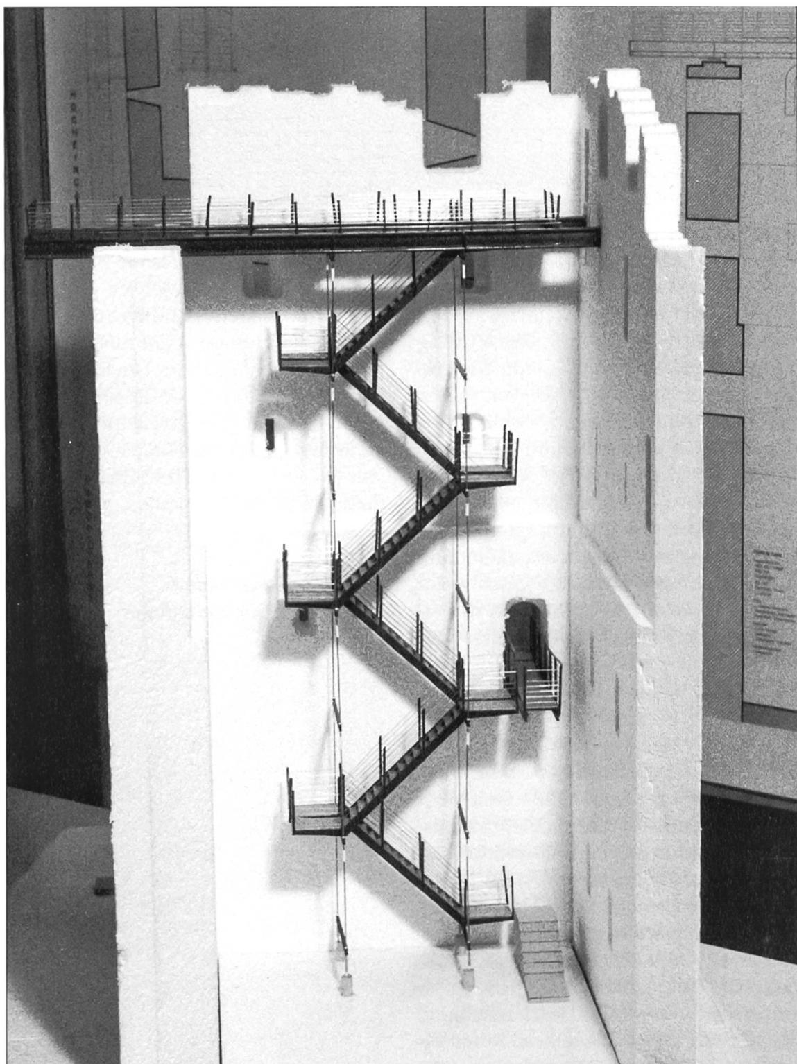
*Die Treppe wird an den Eisenträgern, die die Aussichtsplattform tragen, in den Turm hineingeht. Die Zugstangen sind unten im Felsen verankert. So entsteht eine leichte Konstruktion, die den Blick auf die Mauern uneingeschränkt freigibt.*
