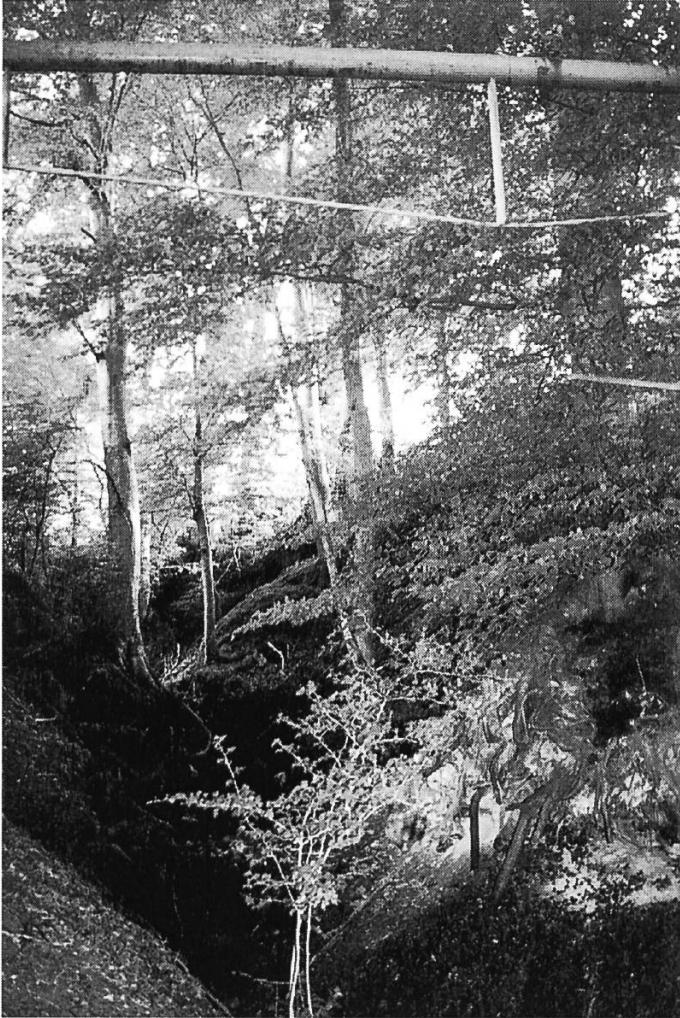
Die Wasserversorgung zum Reservoir nach Uffikon ist 1,7 km lang und überquert mit einer Tragkonstruktion ein tiefes Bach-tobel. (Foto: Oswald Zemp)
