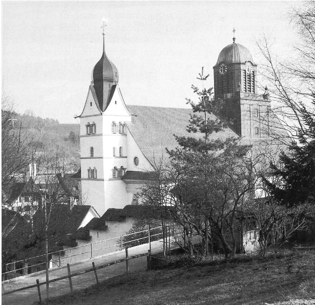
Die Pfarrkirche St. Peter und Paul Willisau nach der Restauration 1995–1997.
