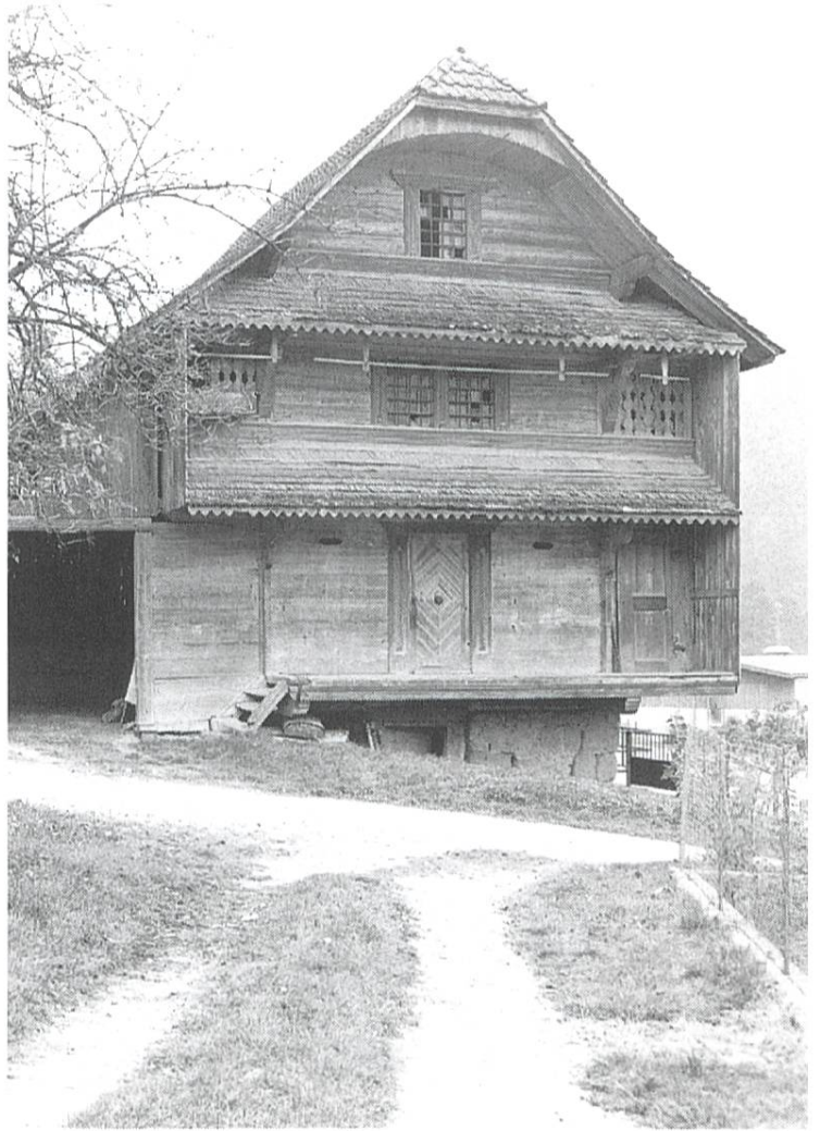
Abbildung 11: Der von Anton Röllli 1825 erbaute Speicher. Der im Text erwähnte Webkeller befand sich unten rechts aus- sen.
