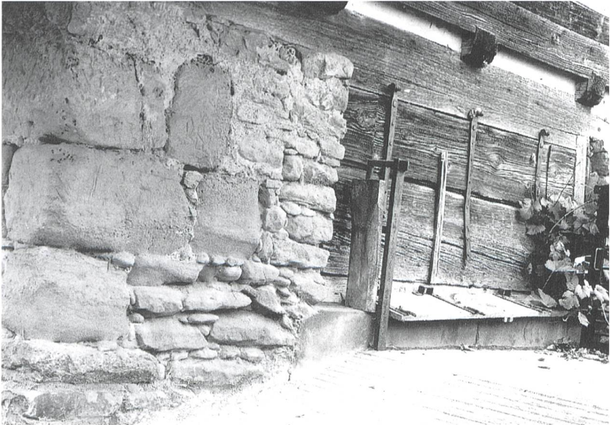
Abbildung 12: Äussere Teilansicht des Webkellers von der Westseite gesehen. Typisch für einen solchen Keller waren die seitlich in die Wände eingelassenen aufklappbaren Türen.
