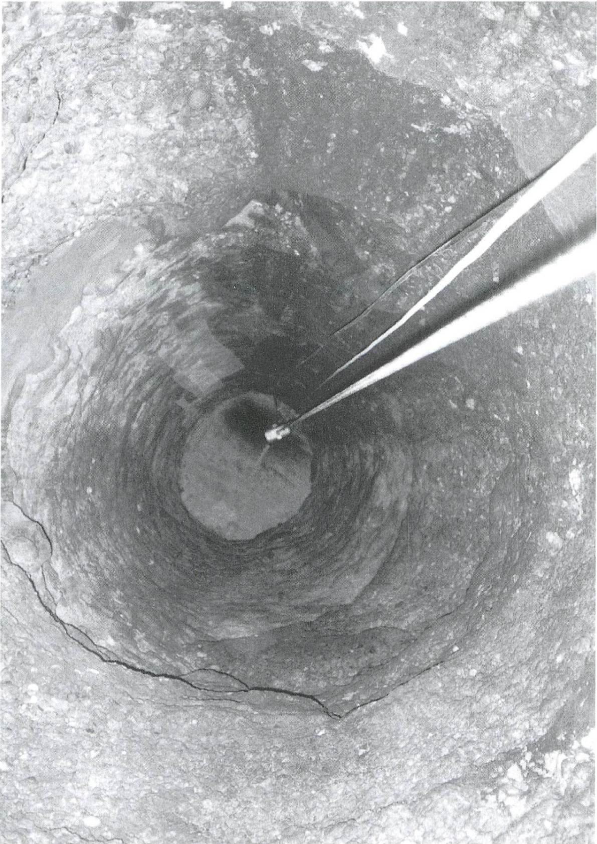
Sodbrunnen: Blick aus rund 15 Metern Tiefe gegen den Deckel des Sodbrunnens. Auf rund 60 Metern Tiefe des Brunnens liegen Schutt und Baumstrünke. Am Rand des Bildes sind Kettenzug, Sicherungsseil und Scheinwerferkabel sichtbar.
