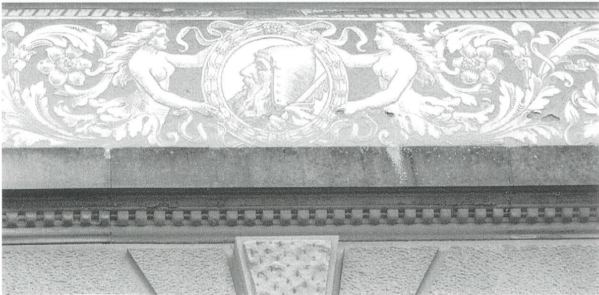
Detail vom Sgraffito-Zierwerk (Kratzputz) an der Hauptfassade.
