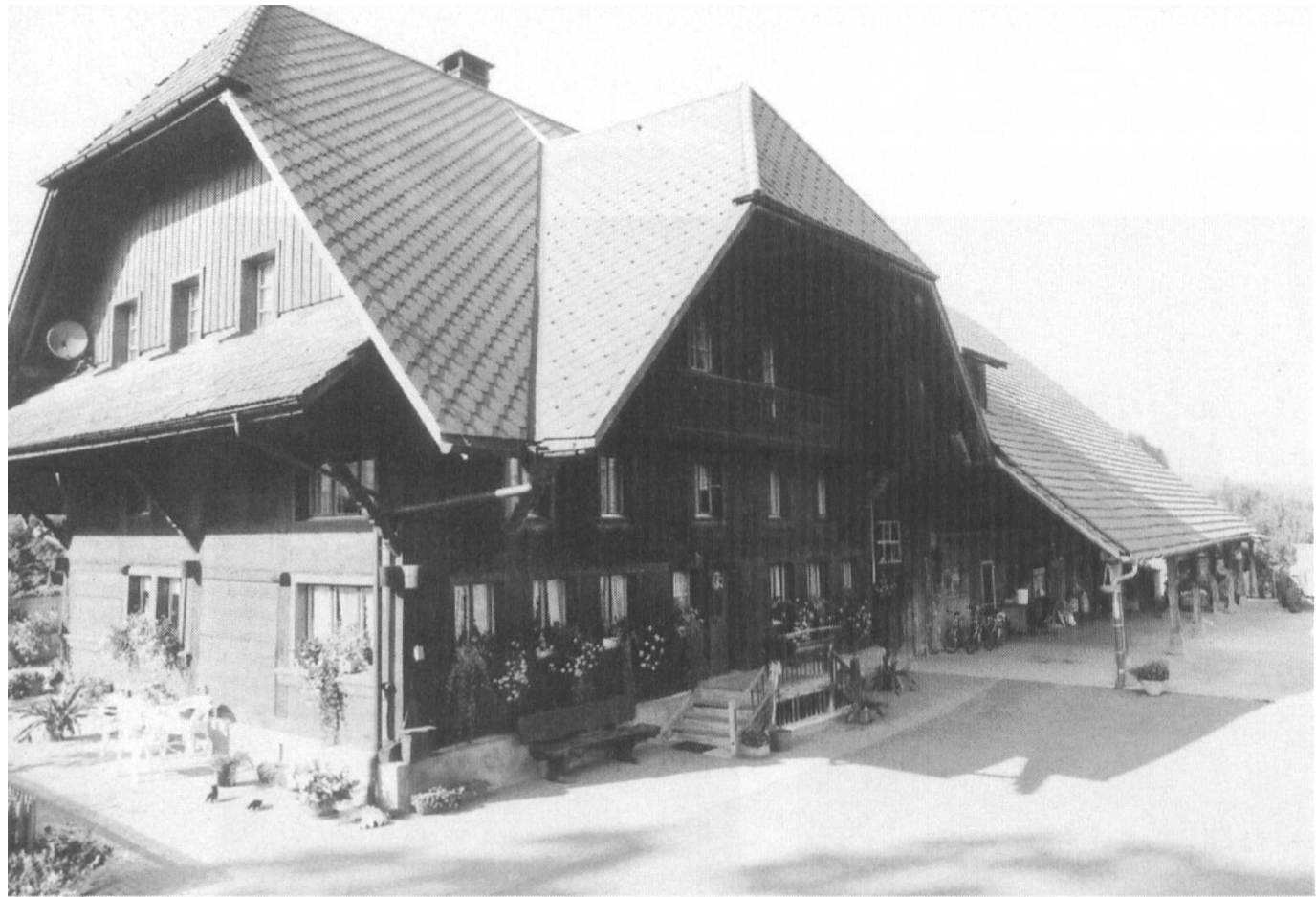
Hof Vordergesserswil mit kanneliertem Gesimse und gedrehten Dachträgern. Gebäude um 1800 erstellt.
