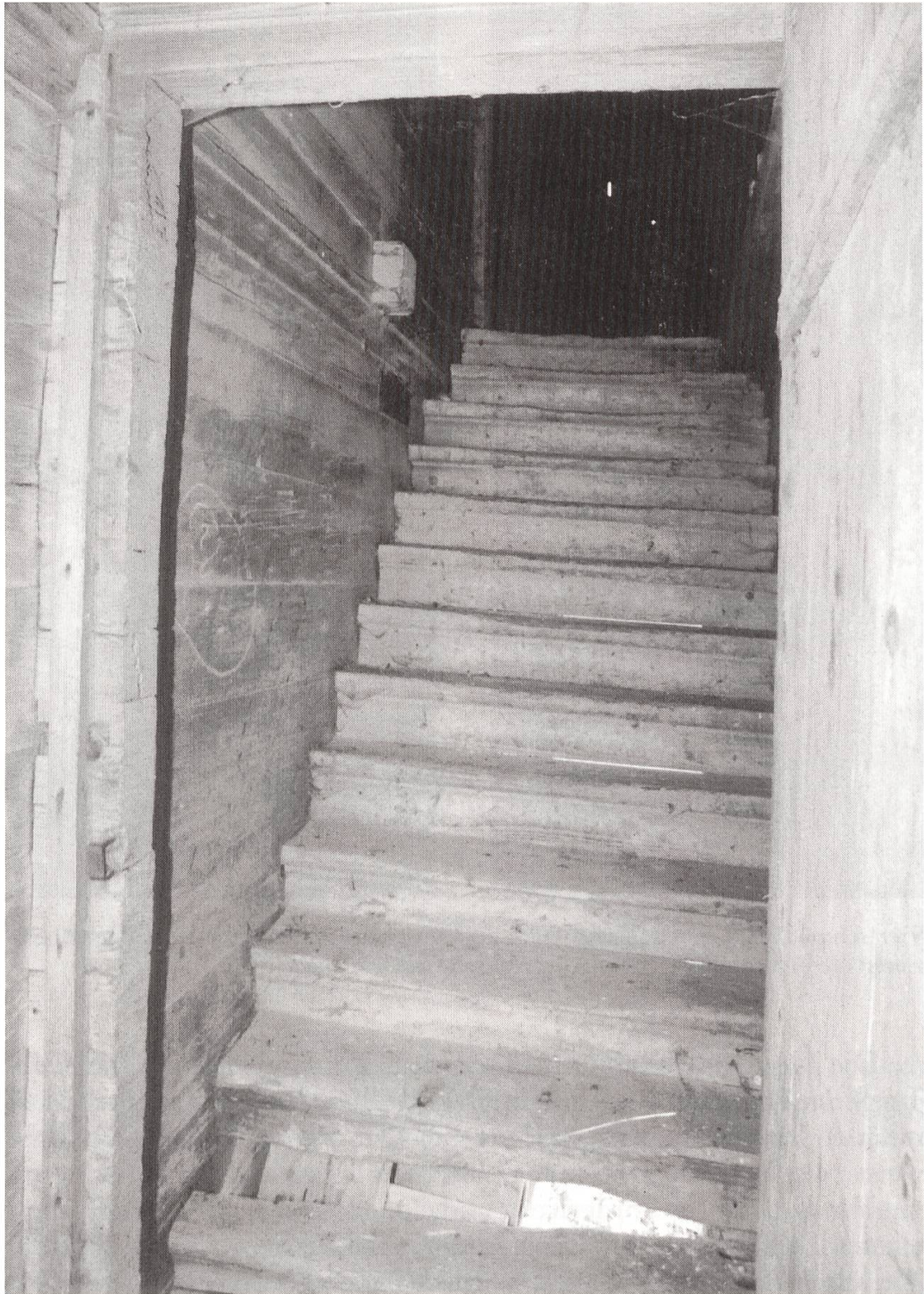
Originale Blockstiege aus massiven dreieckförmigen Holzspalten hergestellt.
