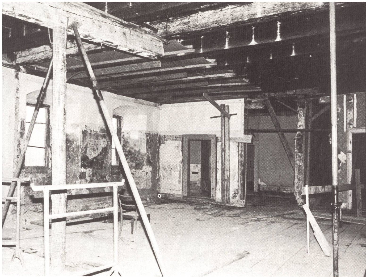
Eine durchgehende Boden- und Deckenkonstruktion wies darauf hin, dass im westlichen Teil des Erdgeschosses nur ein Raum bestanden hatte.
