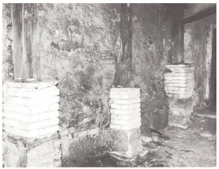
Die Auflager der Tragbalken waren zum Teil abgefault und mussten unterstützt werden.
