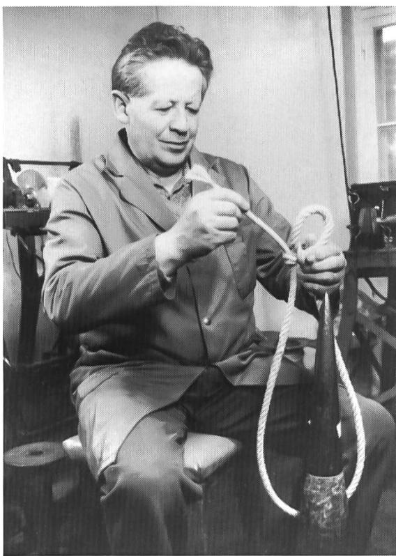
Herstellung einer Schlaufe am Lätsch-Stock. Das dünneren Ende des Strickes wird durch das «Auge» des dickeren gezogen.
