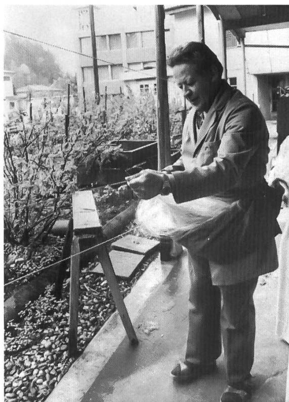
Der Seiler führt behutsam das Leitholz, welches durch die Verdrehung der Litzen vorangetrieben wird.
